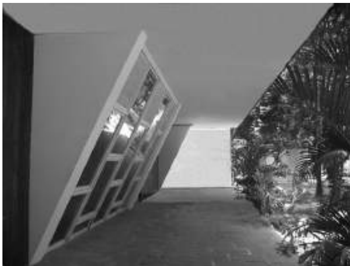
Figura 14: Tratamento dado às esquadrias do terraço no pavimento térreo
