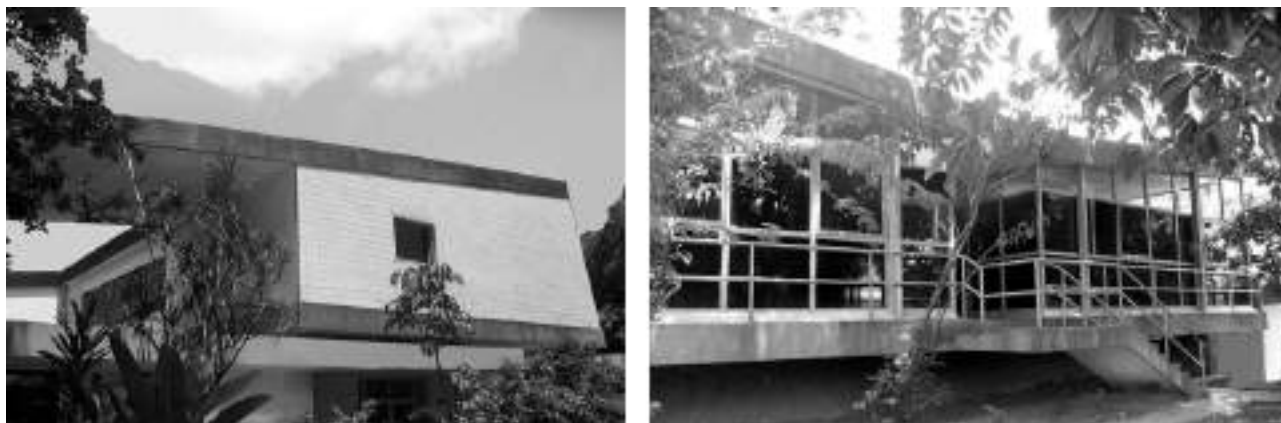
Figura 15: Tratamento dado à cobertura em asa de borboleta.
