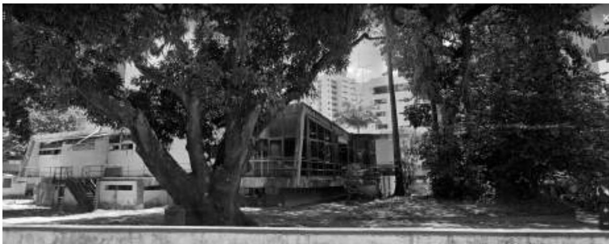
Figura 7: Implantação da casa entre a vegetação abundante, antes da demolição.
