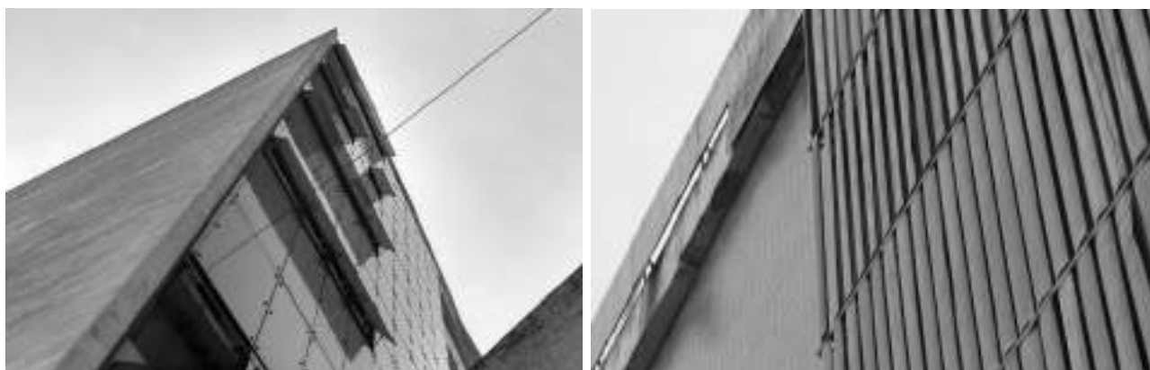
Figura 14: Esquadrias e brises presente no TMSC
