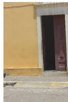
Figura 21: Ponto 05 – guia rebaixada
