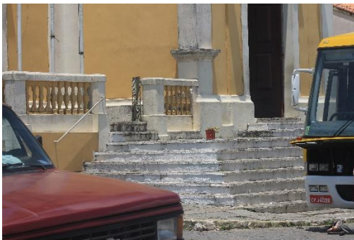
Figura 20: Ponto 04 – calçadas e escadas
