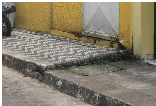
Figura9: Ponto 27 – largura e desnível da calçada
