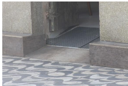
Figura 23: Ponto 14 – largura da calçada
