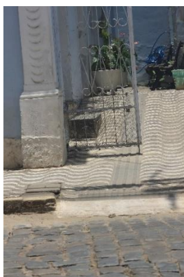
Figura 26: Ponto 24 – guia rebaixada entrada de veículos
