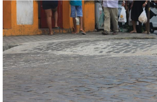
Figura 18: Ponto 19 – largura e desnível da calçada
