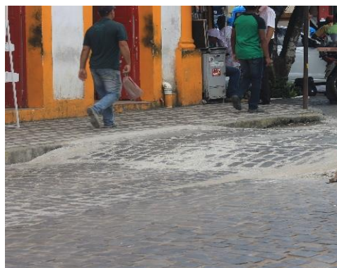
Figura 40: Ponto 22 – Faixa elevada
