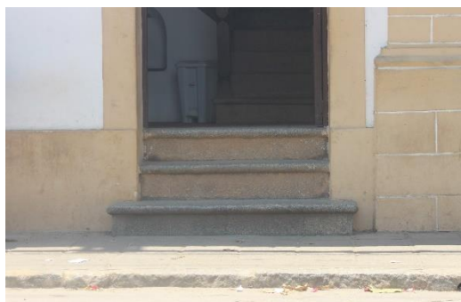
Figura 24: Ponto 15 – largura da calçada
