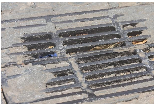
Figura 15: Ponto 8 – Boca de lobo
