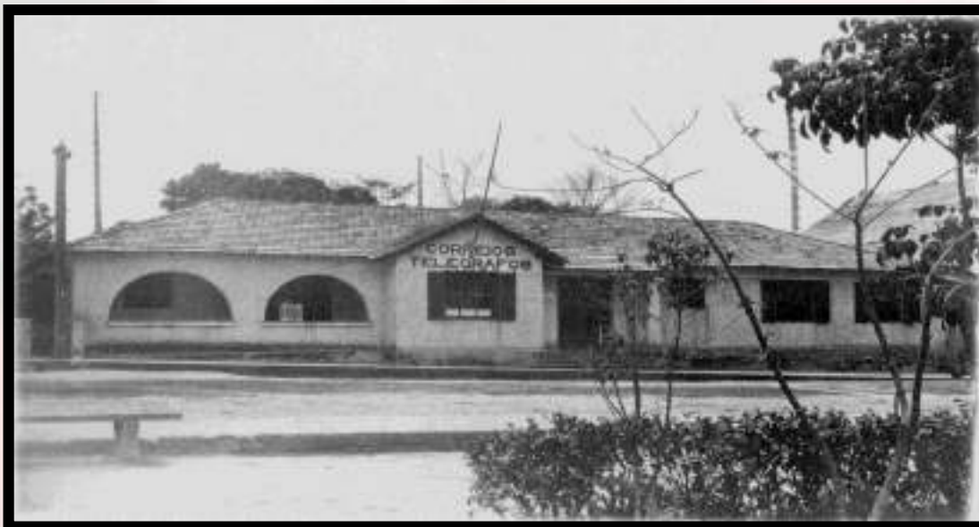
Agência dos Correios e Telégrafos (D.C.T.). Data: Década de 1940 (Figura 2).
