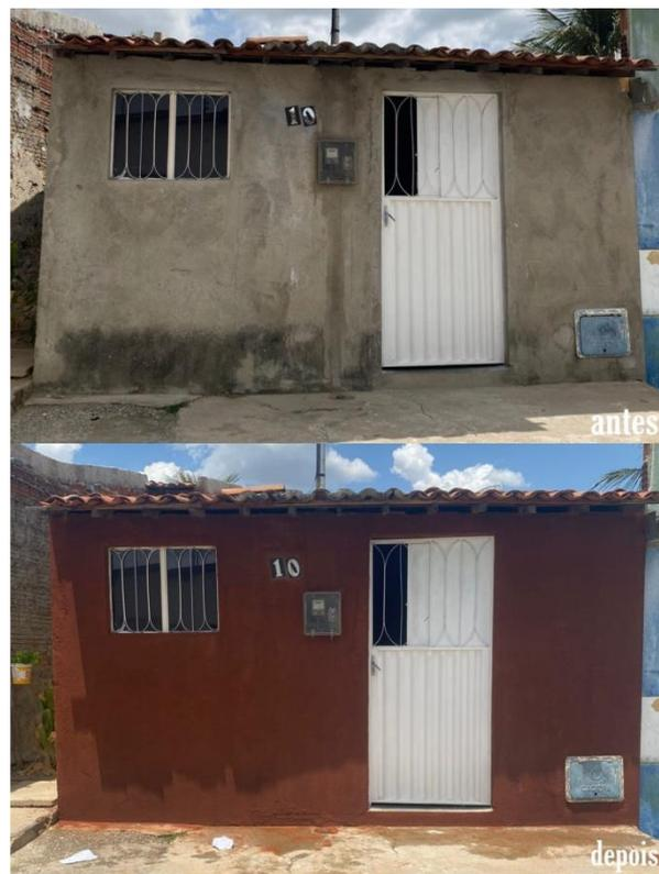
Figura 12 – O antes e o depois da casa nº 3 beneficiada com a pintura da fachada com geotinta.
