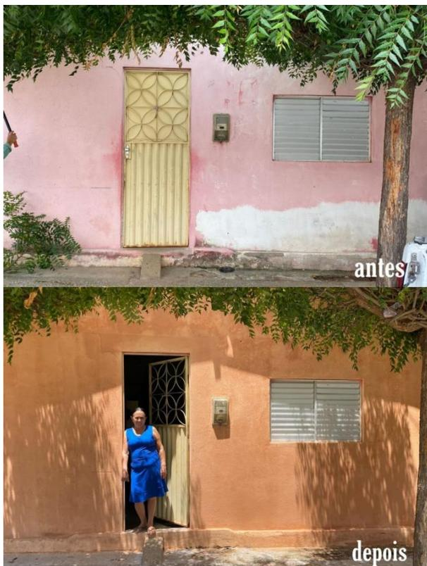
Figura 11 – O antes e o depois da casa nº 2 beneficiada com a pintura da fachada com geotinta.
