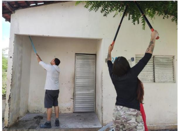
Figura 8 – Aplicação do selador (água) para iniciar as pinturas.
