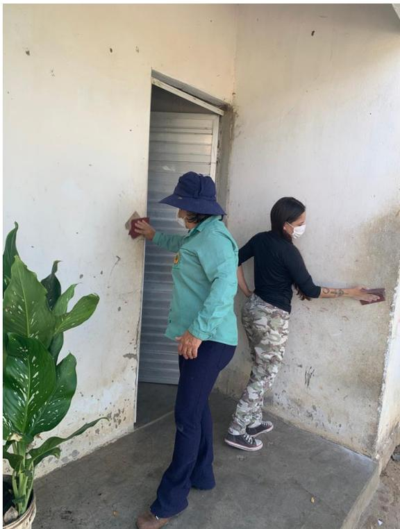
Figura 7 – Lixamento das paredes.
