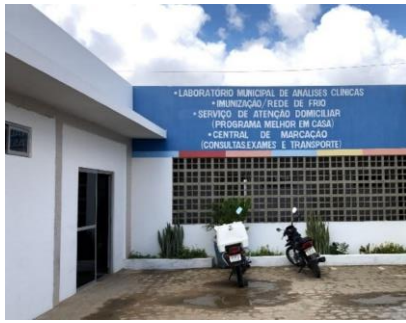
Figura 1 – Fachada do Laboratório Municipal de Análises Clínicas de Cuité/PB.
