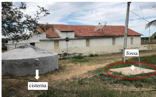
Figura 6 - Cisterna de abastecimento de água e fossa para disposição de esgoto.
