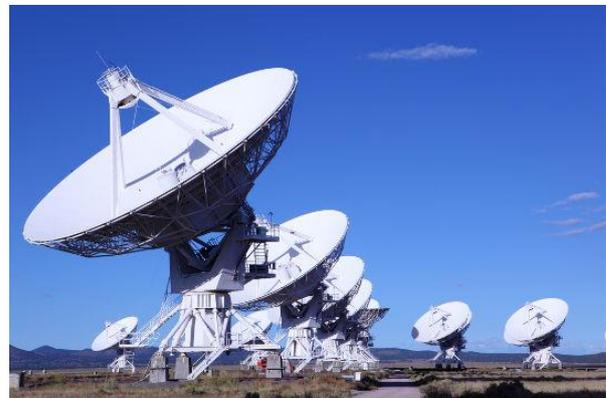
Figura 2: Um **array**. Conjunto de vários radiotelescópios/antena que se comportam como uma única e gigantesca antena.
