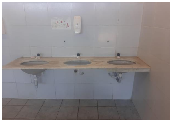
Figura 6 – Pias do banheiro feminino
