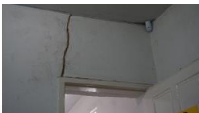
Figura 6: Registro da visita técnica 2022
