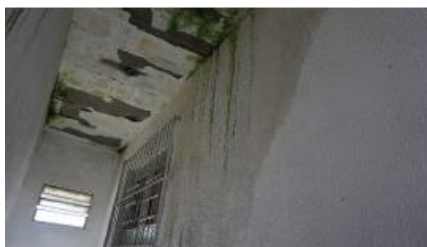
Figura 5: Registro da visita técnica 2022
