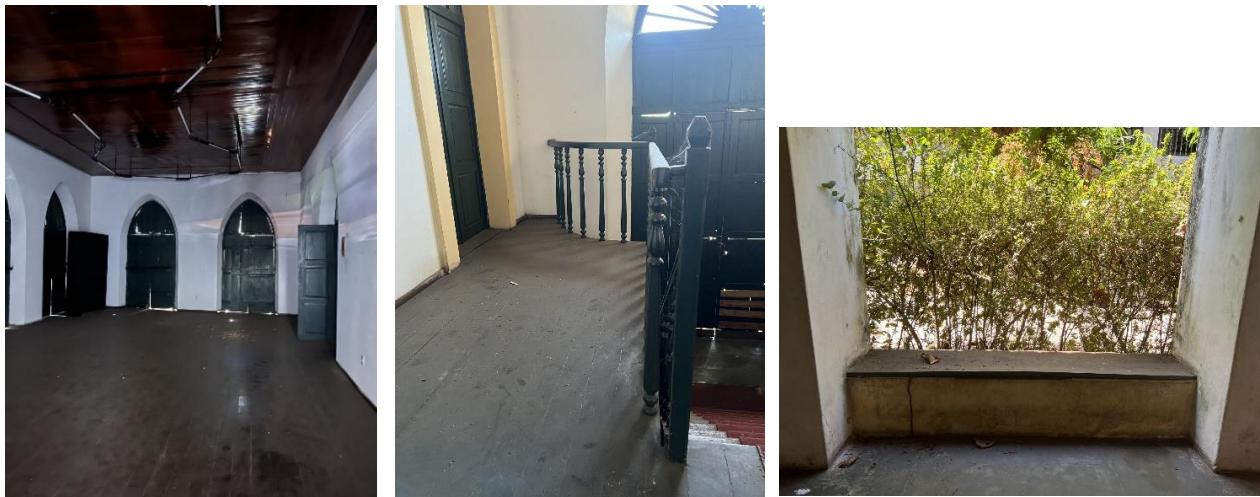
Figura 8: Casa do Barão. Tomadas internas: sala de receber, detalhe hall acesso secundário, banco entre pilares no piso térreo.
