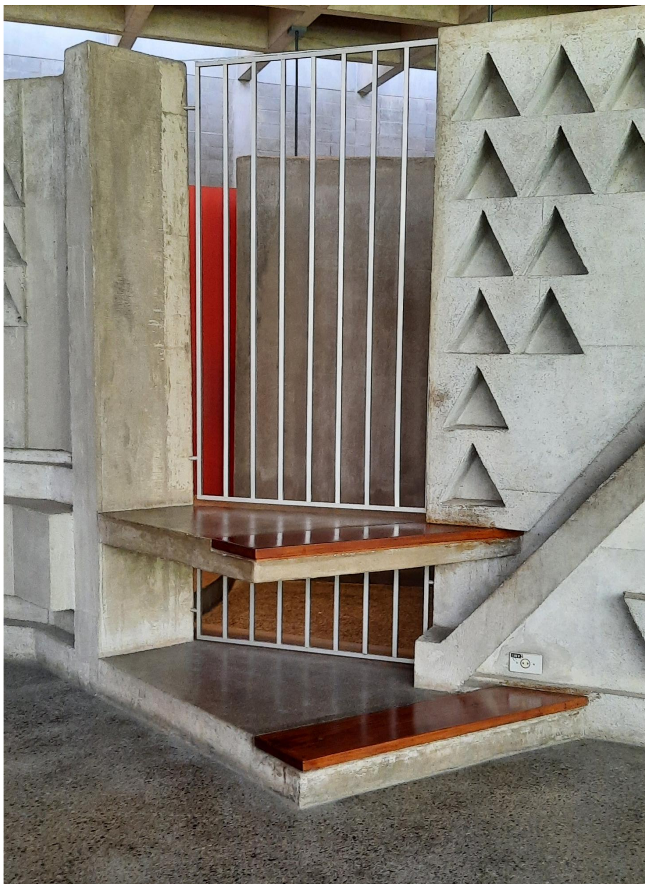
Título: Oratório moldado em concreto com apoios em placas de madeira
