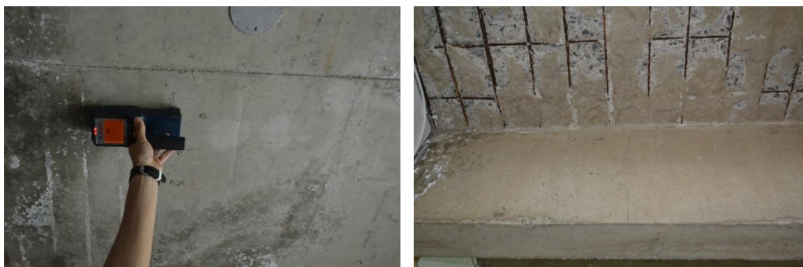
Figura 19: Realização de ensaios não destrutivos na Casa Broos utilizando o pacômetro digital
