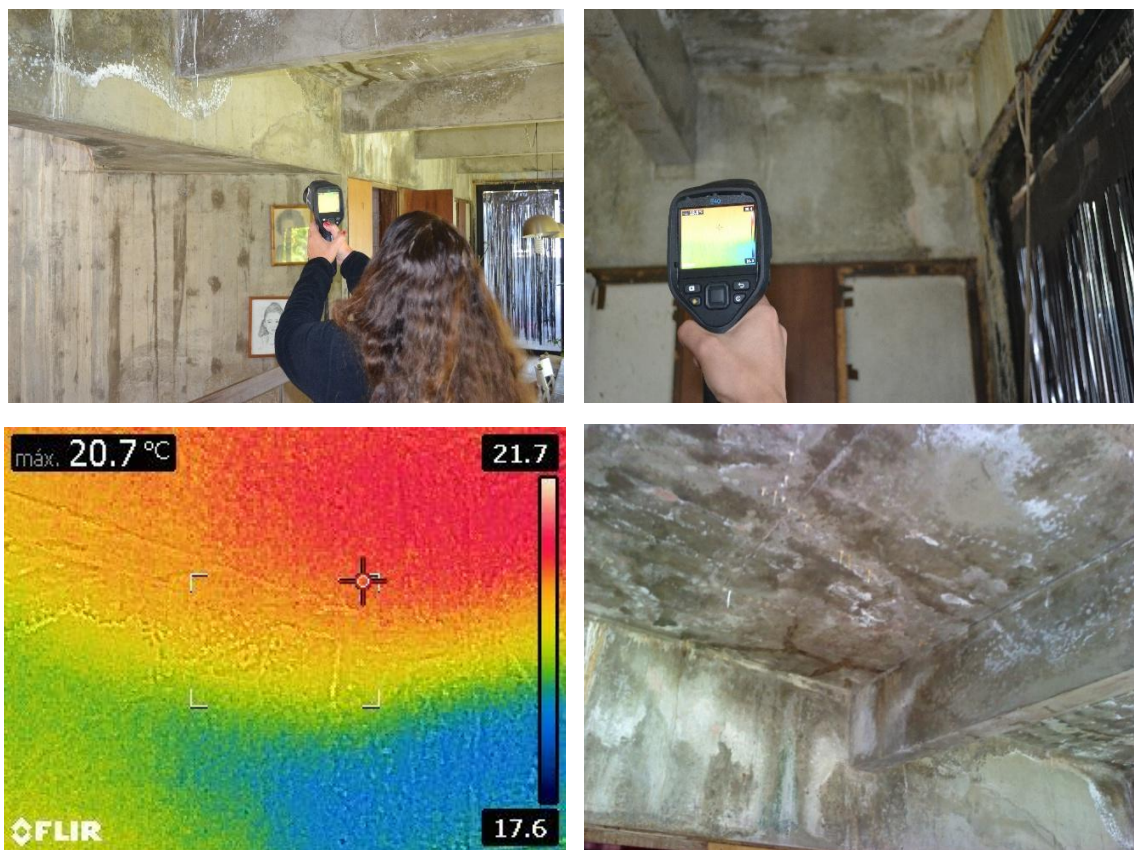
Figura 18: Realização de ensaios não destrutivos com termo câmera Flir modelo E40 detectando umidade em materiais porosos, fissuras e delaminações no interior de estruturas de concreto.
