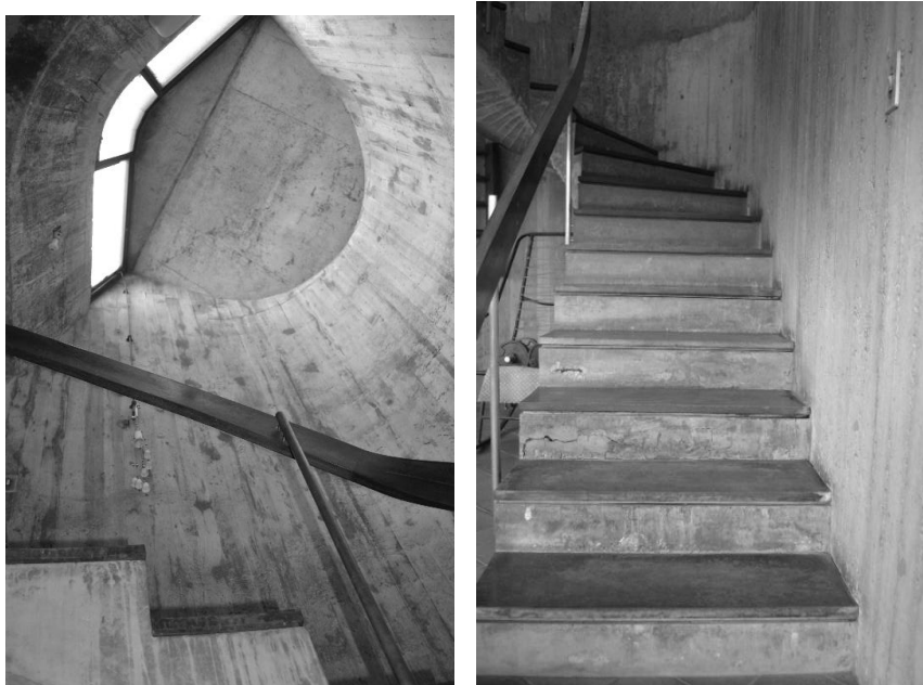
Figura 16: Detalhes da escada interna de acesso.
