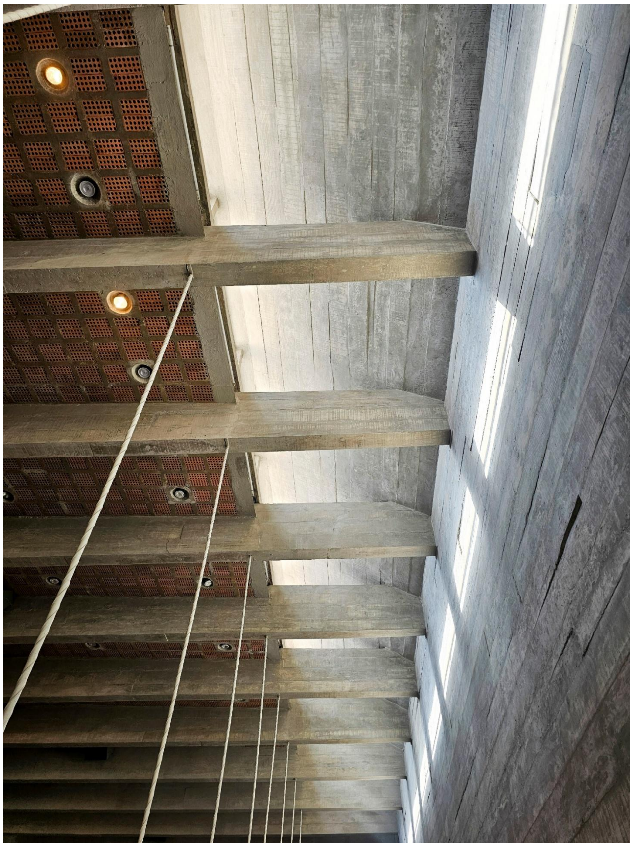
A rica solução técnica atrelada à uma plasticidade arrojada e sutil de Broos, que trabalhou com elementos cerâmicos perfurados no forro, e a potente estrutura em concreto armado aparente, mas possuidora de muita leveza. Fotografia de Alcilia Afonso. Julho de 2026.
