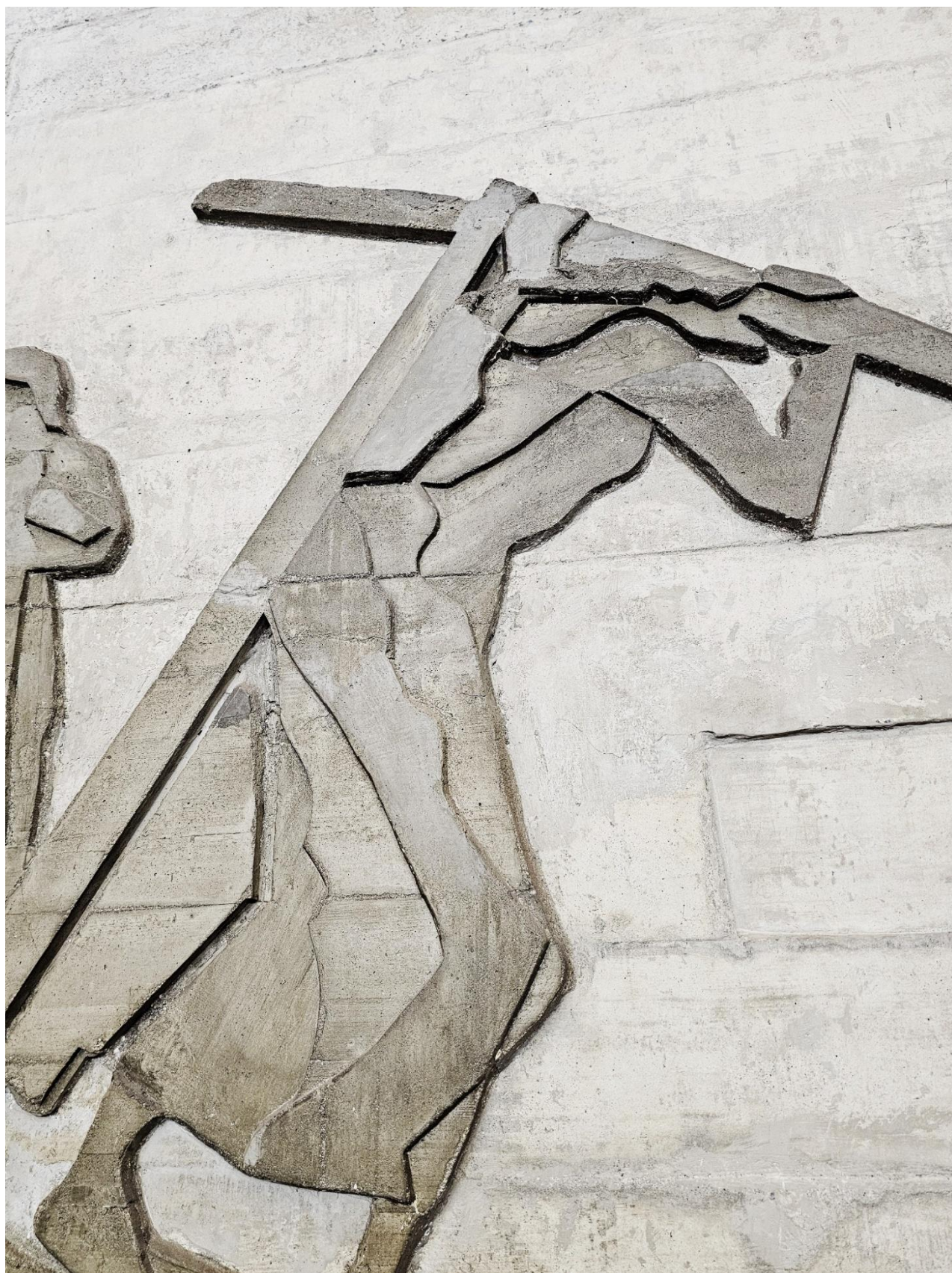
Detalhe do painel escultórico em concreto existente na parede lateral esquerda da nave. Fotografia de Alcilia Afonso. Julho de 2026.
