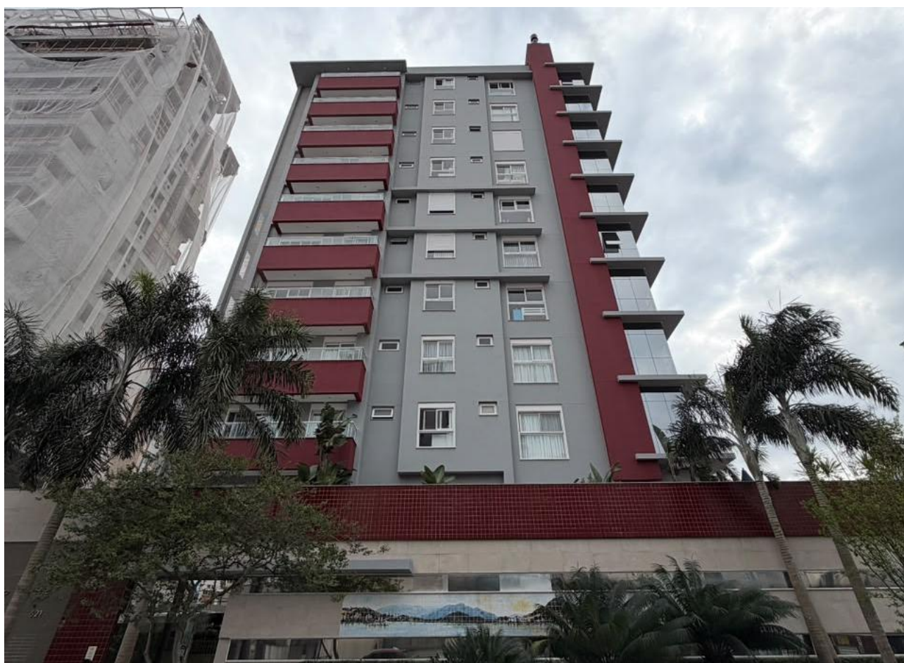
Figura 5: Terreno da Casa Zipser na região central de Florianópolis, após a demolição da edificação residencial unifamiliar, substituída por um novo empreendimento multifuncional em altura.
