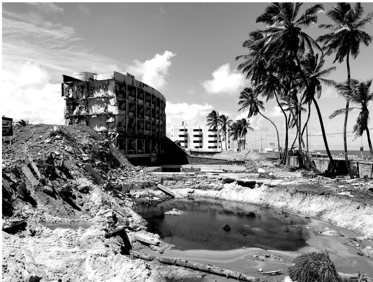
Título: Dia 10 – A demolição do Hotel Internacional dos Reis Magos atinge a metade da estrutura
