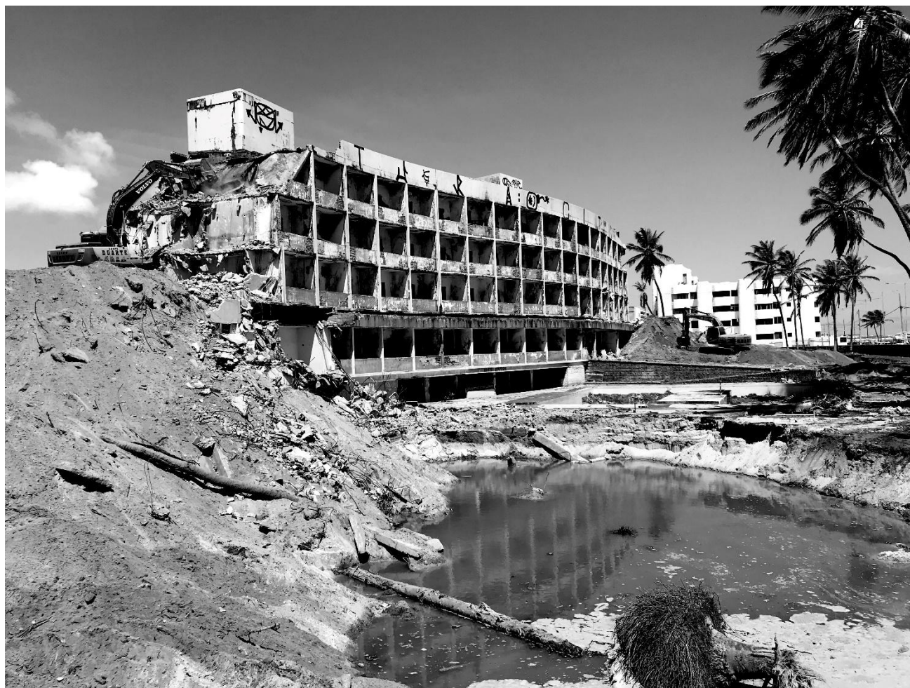
Título: Dia 05 – Início da demolição do Hotel Internacional dos Reis Magos
