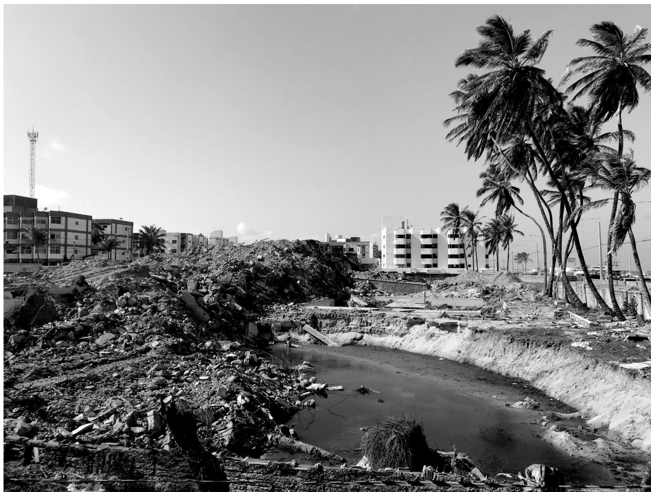
Título: Dia 20 – Conclusão da demolição do Hotel Internacional dos Reis Magos
