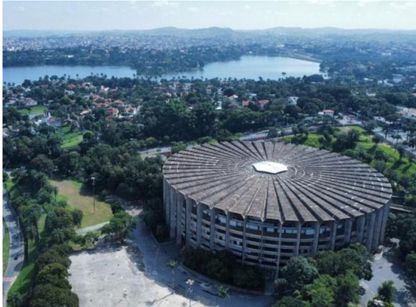
Figura 7: Estádio do “Mineirinho” de Belo Horizonte.
