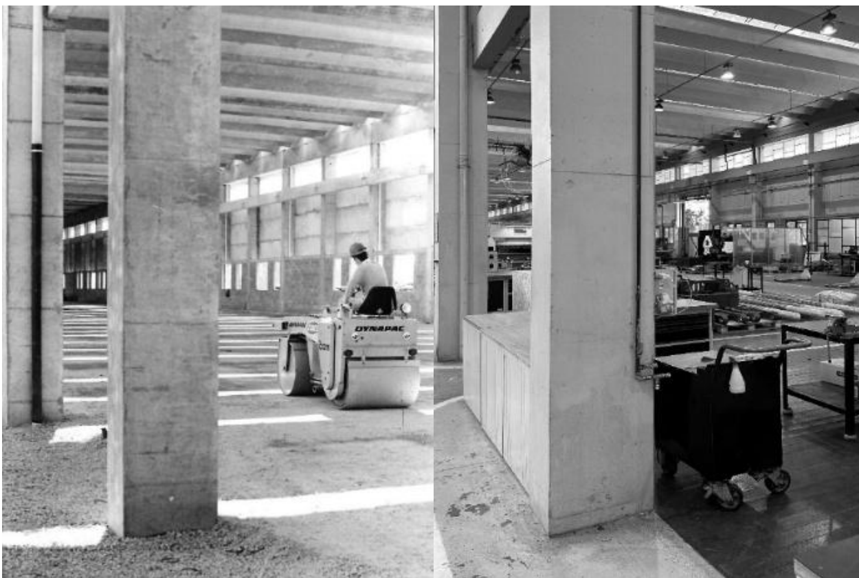
Título: Da terra ao piso, o pilar pré-moldado vendo o processo de construção.
