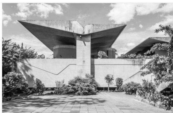
Detalhe da solução estrutural que projetou uma cobertura em duas águas, tipo asa de borboleta em concreto armado. O volume da casa fica protegido climaticamente graças aos grandes beirais que conferem ainda leveza ao volume brutalista. Fonte: W. Abdalla
