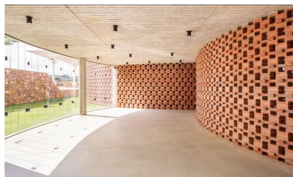
Processo projetual da criação de peles protetoras climáticas Utilizando tijolos maciços. Academia Escola Unileão. 2018. Juazeiro do Norte – CE. Fonte: Foto de Joana França. https://www.linsarquitetos.com.br
