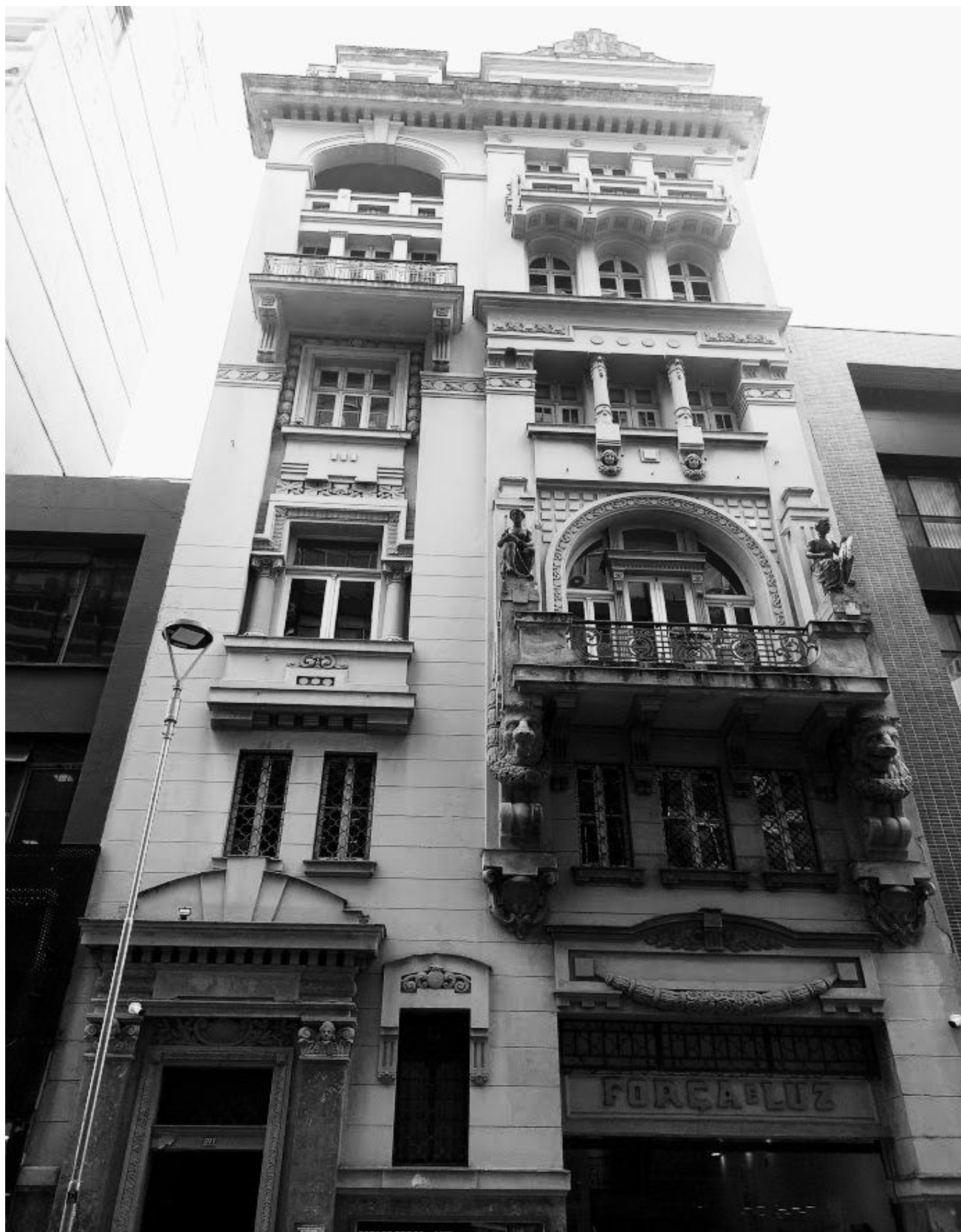
Espaço Força e Luz | Memorial Erico Verissimo e Museu da Eletricidade do RS
