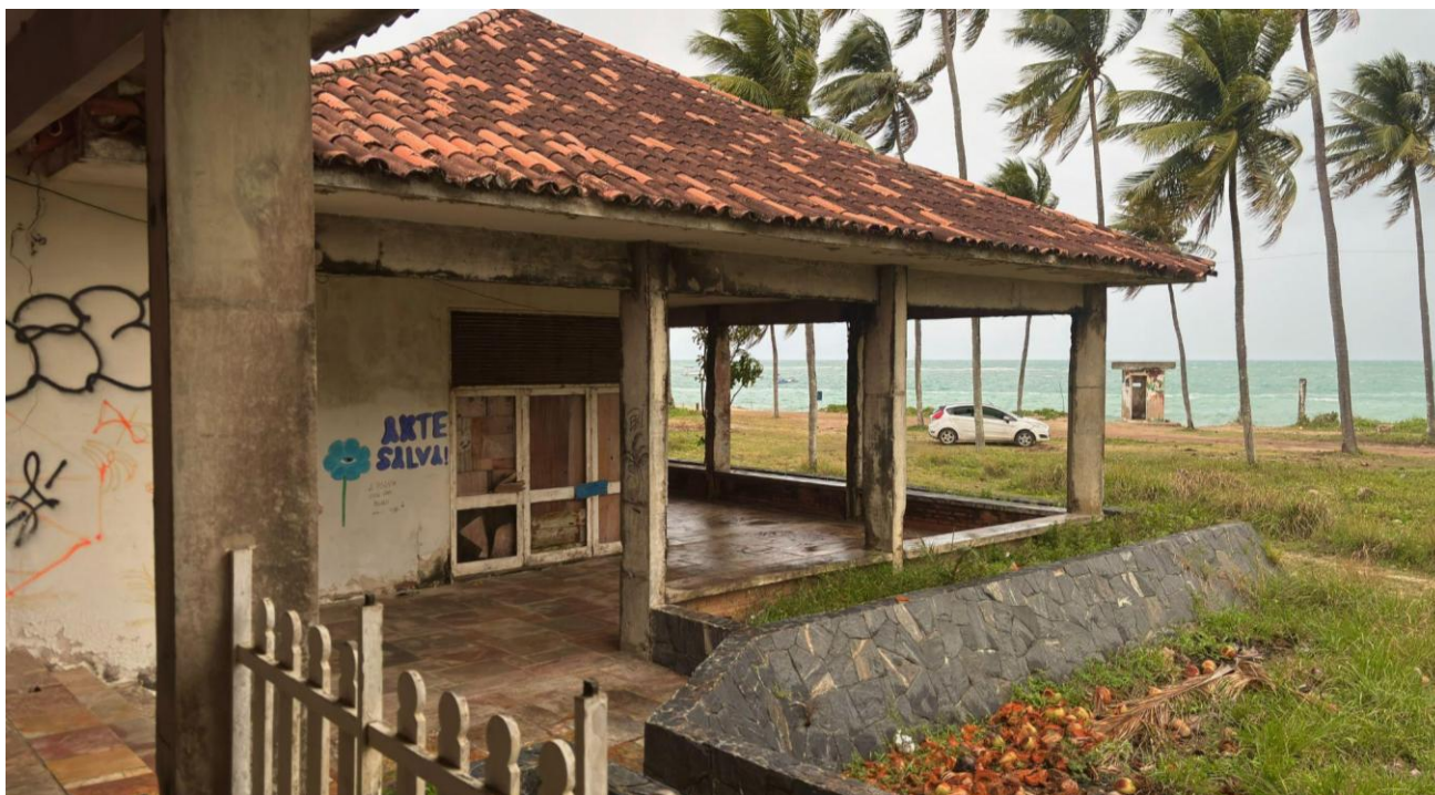
Vista: Varandas de ventilação cruzada.
