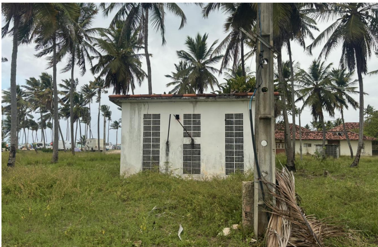
Fundos: vista externa dos cobogós da casa de máquinas.
