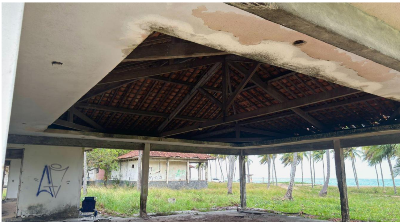
Salão de festa: Detalhes para a cobertura de telhas cerâmicas e estruturas de sustentação.
