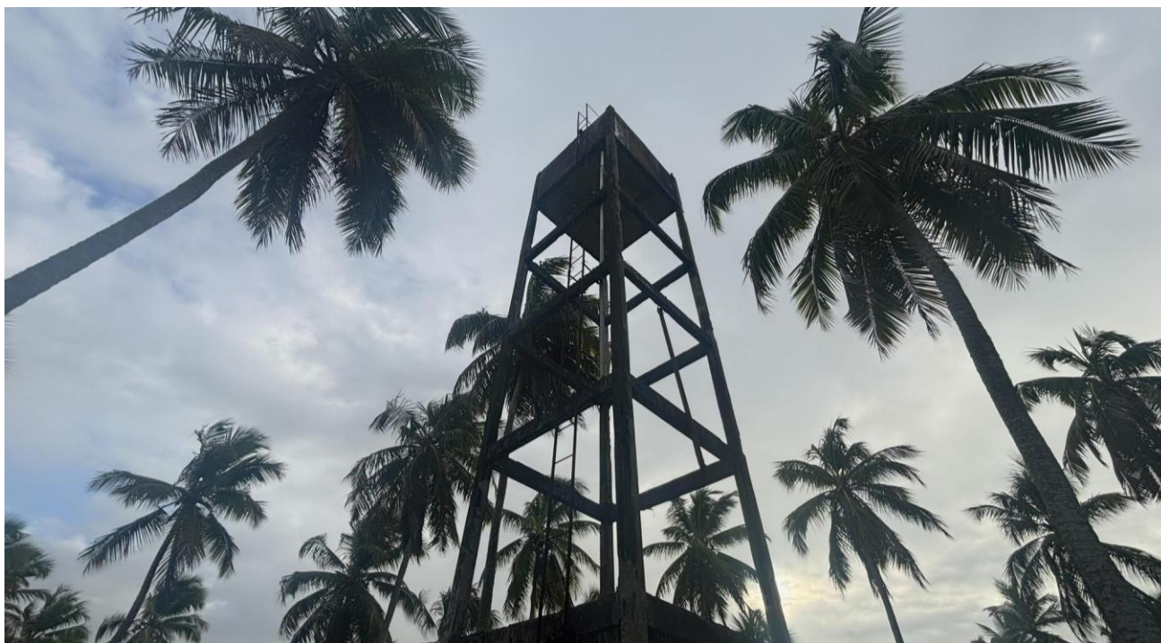
Caixa d'água: estrutura de concreto entre a paisagem dos coqueirais.
