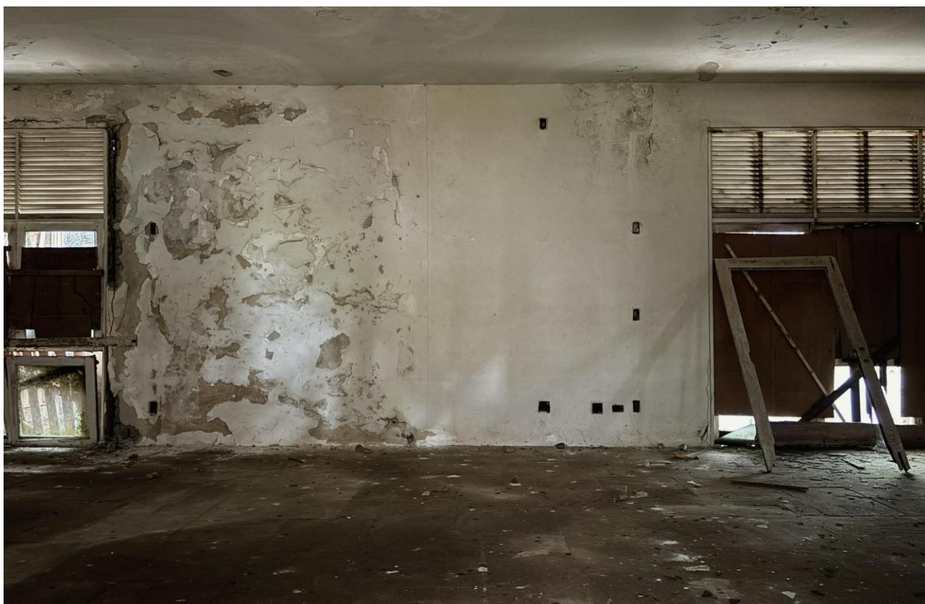
Sala: Detalhes da iluminação na parte interna advindas das venezianas.
