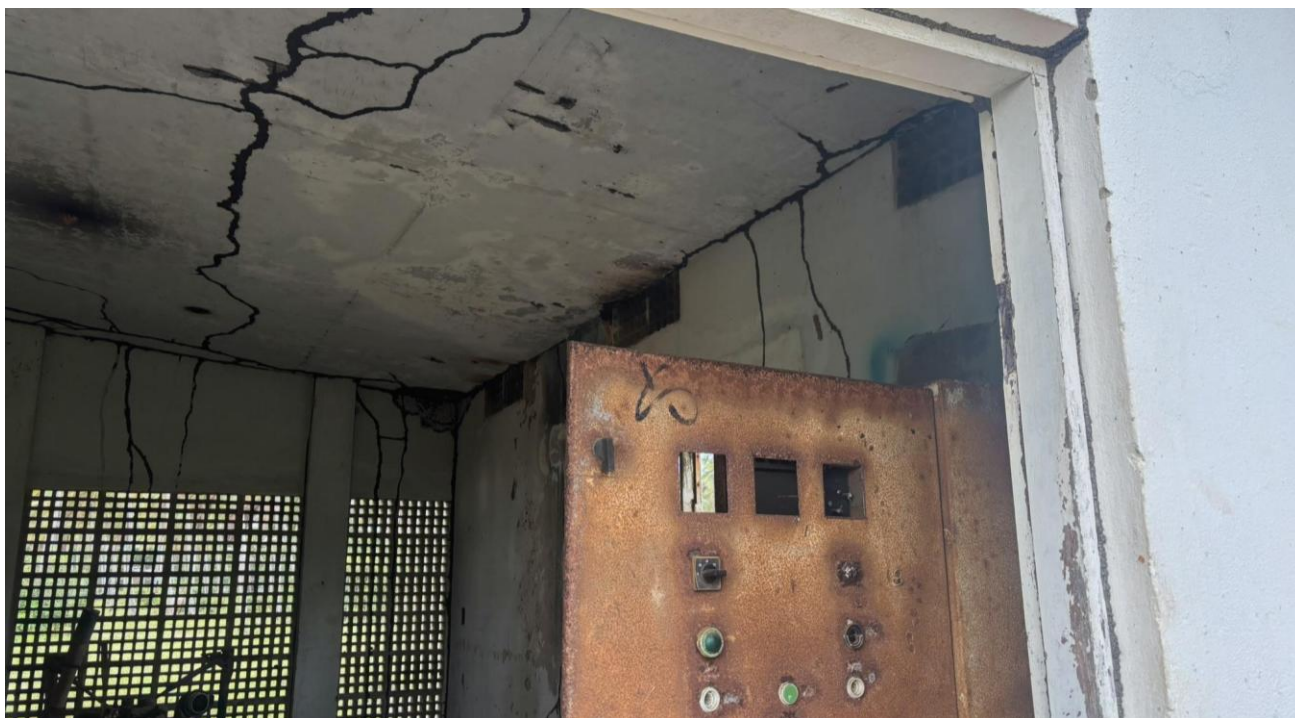
Casa de máquinas: detalhes do maquinário e cobogós aparentes, pela necessidade de ventilação do espaço.
