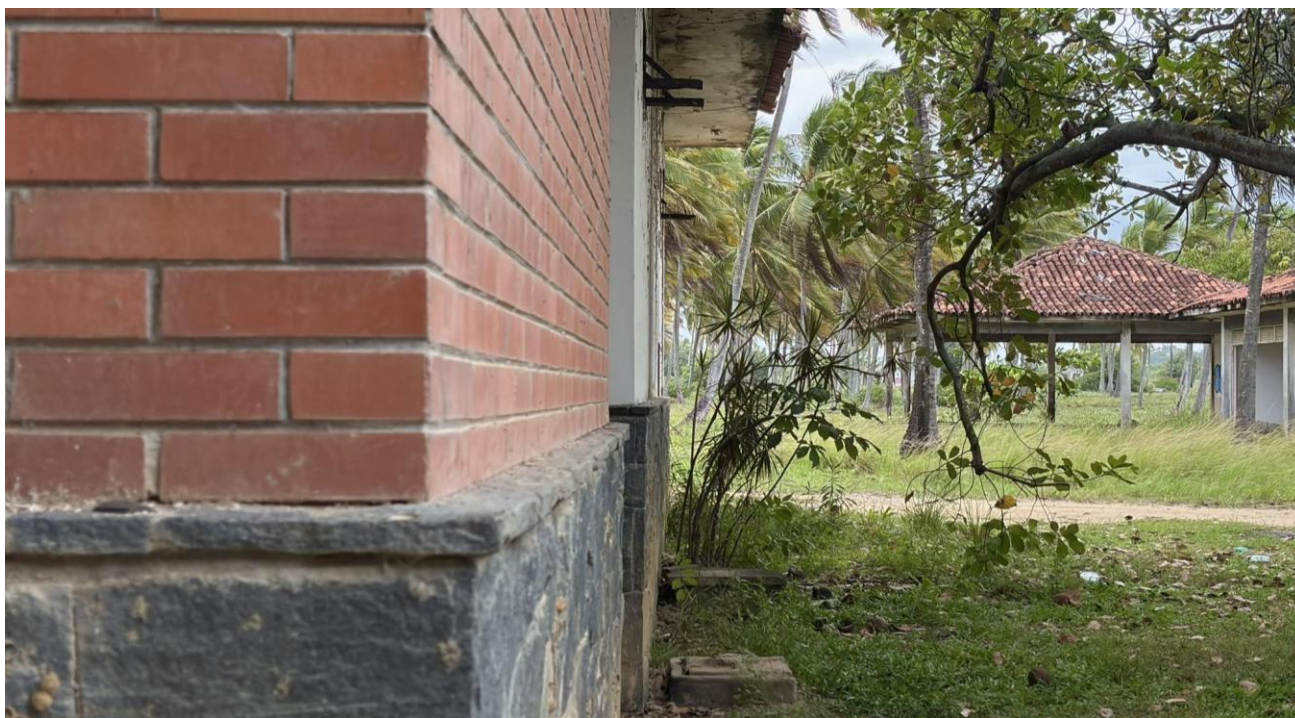
Vista do lazer: Dos fundos da casa, observa-se a estrutura do salão de festas, com telhado de 4 águas.
