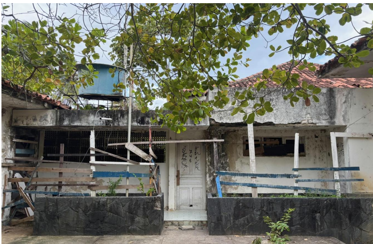
Porta dos fundos: Entrada lateral traseira, composta por cobogós, e com suporte para caixa d'água.
