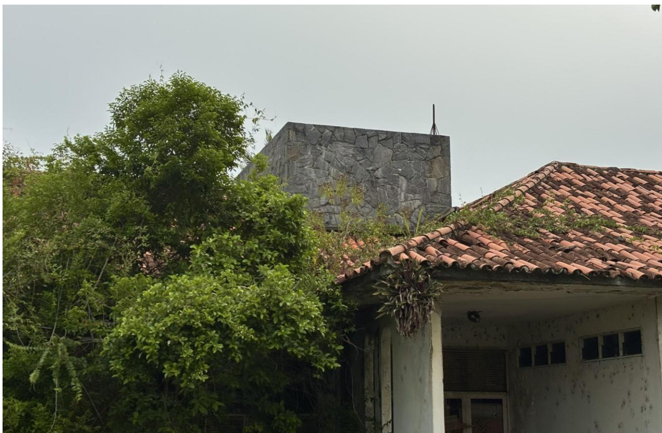
Poço de luz: Detalhes de pedras brutas na abertura zenital da edificação, em contraste com as cerâmicas.
