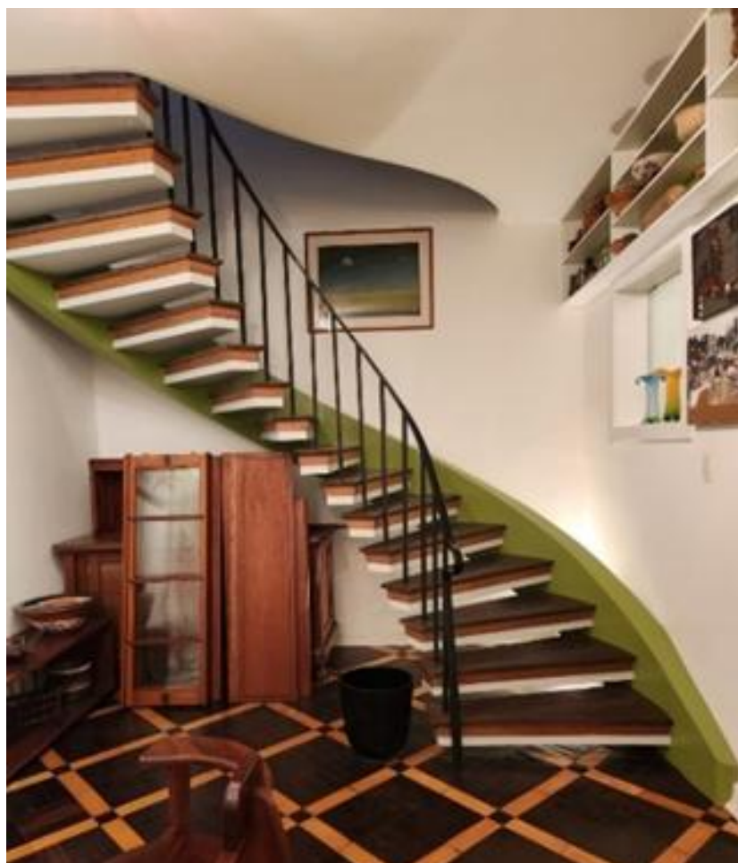
Figura 9 : Escada helicoidal
