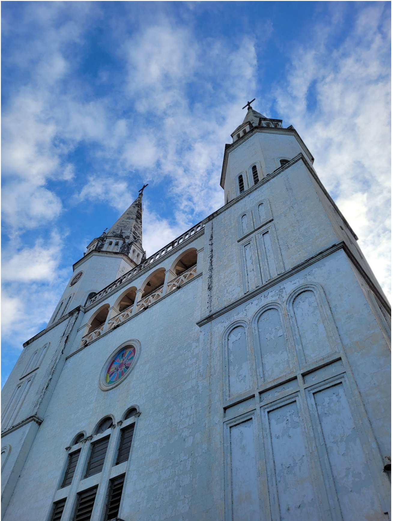
Título: Detalhes das torres na fachada principal da Igreja Matriz de Nossa Senhora do Amparo, 2025.
