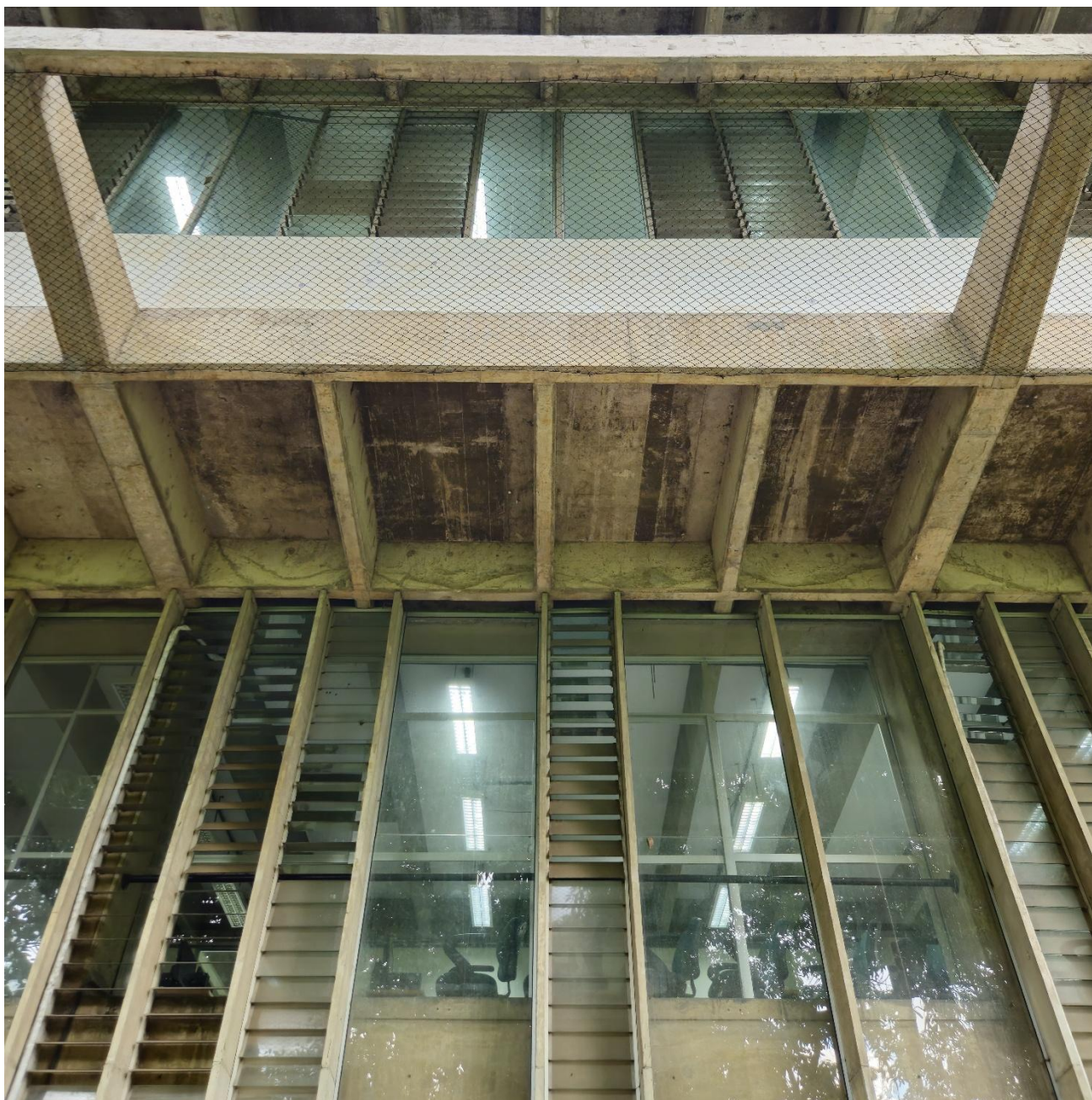
Detalhe da esquadria: Esquadrias divididas por brise-soleil em concreto, trechos em veneziana de vidro criam uma composição rítmica na fachada.
