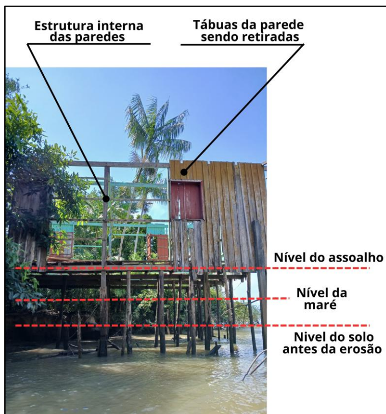
Figura 4: Esquema dos níveis em relação á estrutura em desmanche.
