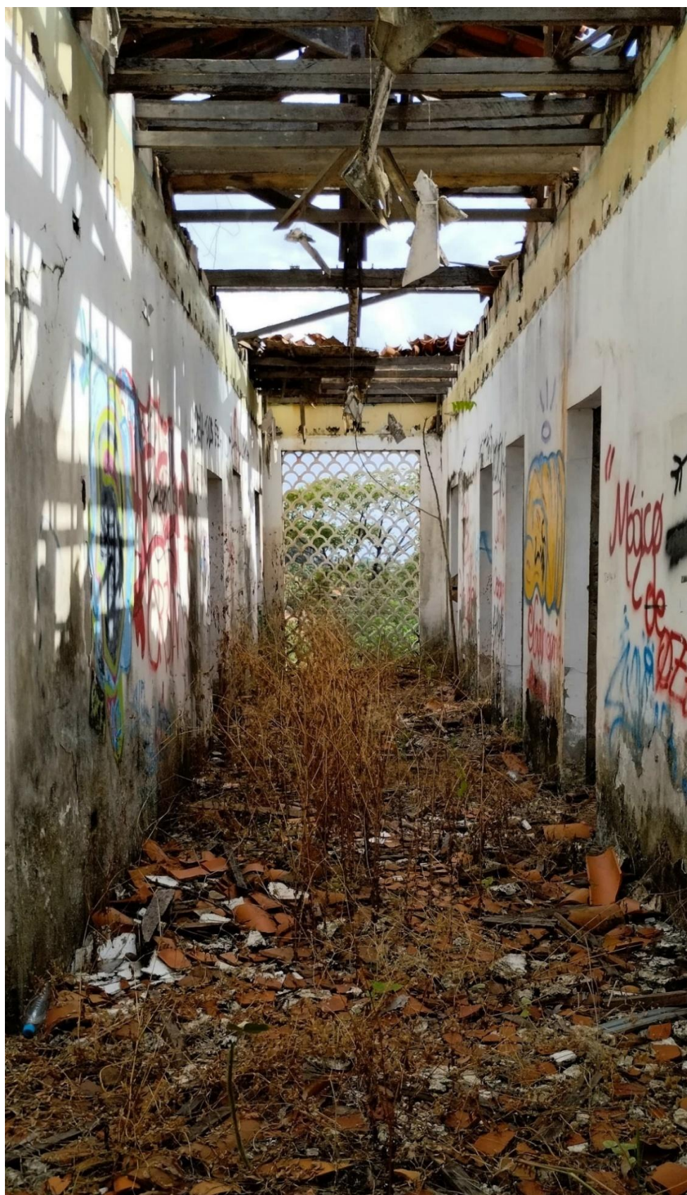
Circulação do pavilhão de quartos: marcado por uma grande esquadria preenchida por cobogó cerâmico na extremidade, apresenta cobertura arruinada, piso tomado por vegetação e resíduos do telhado, paredes com manchas de infiltração e atos de vandalismo e esquadrias removidas.
