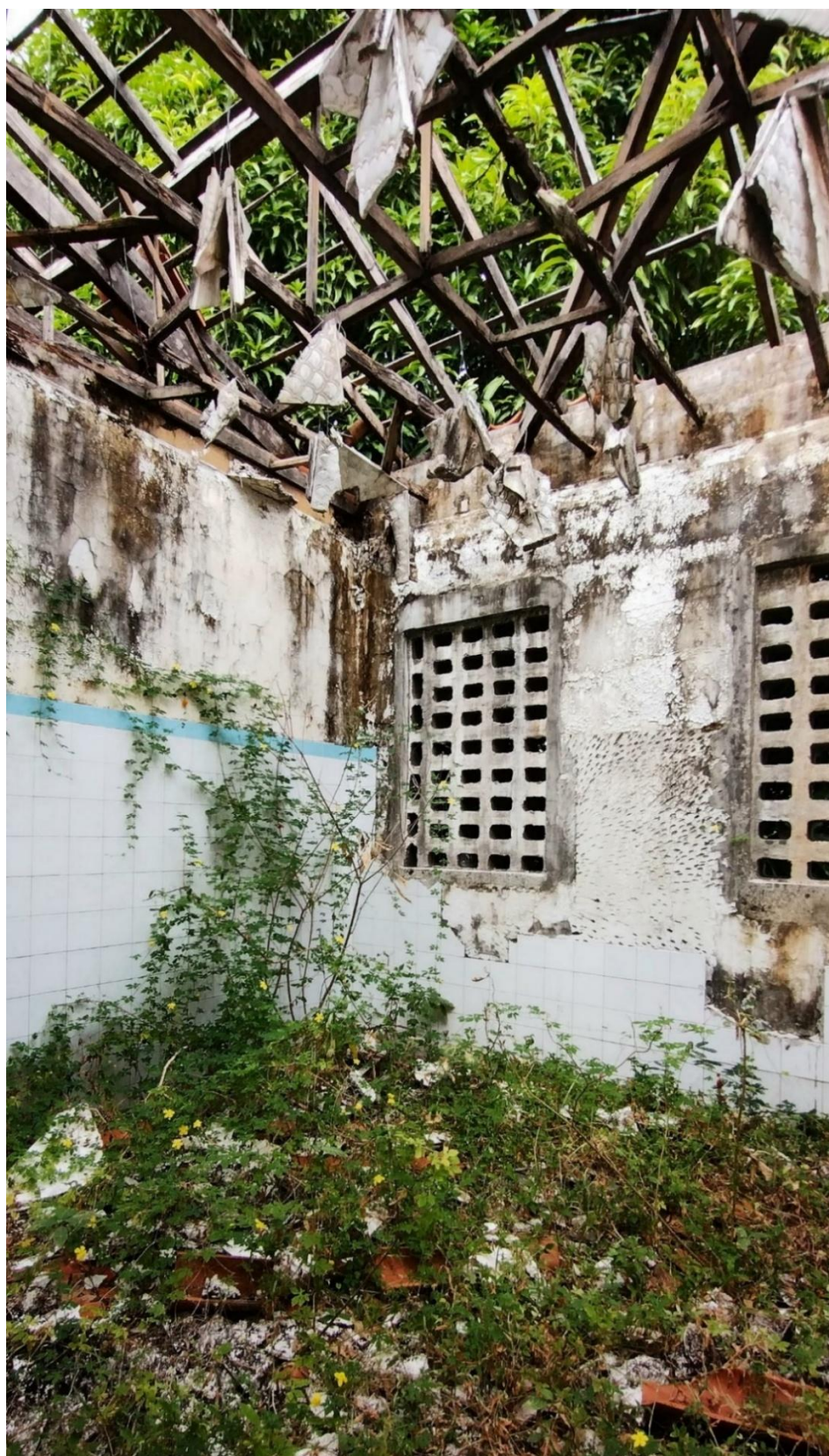
Ambiente de pavilhão: apresenta cobertura arruinada, piso tomado por vegetação, paredes revestidas de cerâmica azul com peças faltando, manchas de infiltração e esquadrias originais substituídas por cobogós de concreto.
