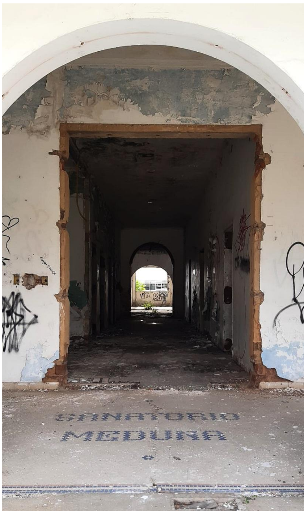
Acesso principal: mostra o amplo corredor de acesso, esquadrias removidas e paredes internas e piso de taco deteriorados resultante da falta de fiscalização, expondo atos de vandalismo. Uma grande moldura bicolor azul e branco destaca o nome do hospital no piso em mosaico de pastilhas cerâmicas.
