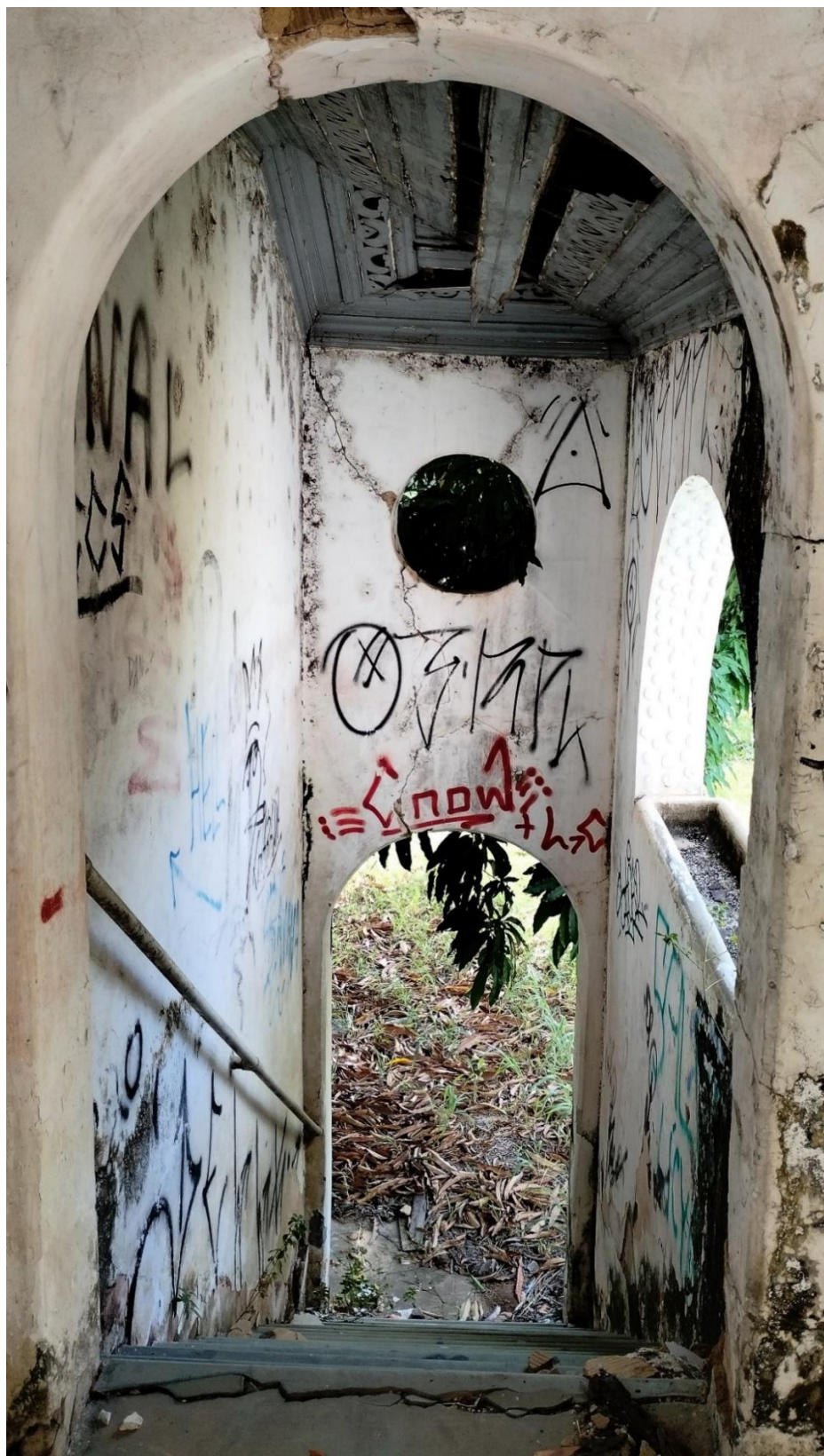
Escada de acesso ao pavimento inferior: possui forro de madeira com moldura rendilhada vazada em estágio avançado de degradação e apresenta trincas em toda a extensão dos arcos, nas paredes, no piso e no óculo, sendo uma patologia que compromete a estrutura, bem como infiltração, que é uma patologia de porosidade, reforçando o estado de abandono que se encontra a edificação.
