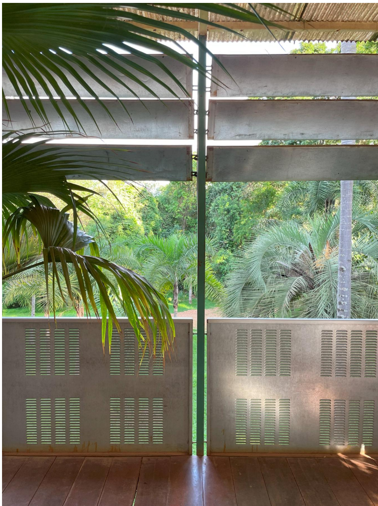
Enquadramento: Guarda corpo e brises em metal.
