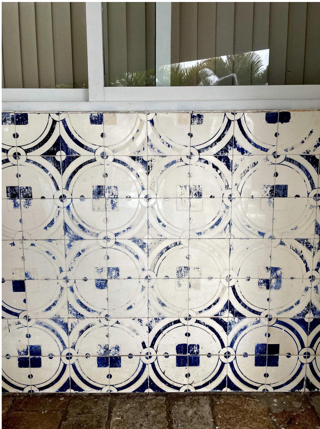
Azulejos Desgastados: Detalhe de azulejos presentes na fachada com desgaste evidente.
