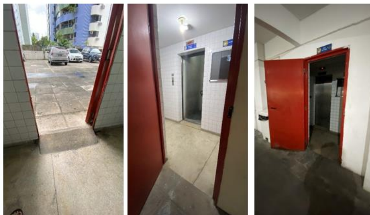
Figura 12: Caixa de escada.
