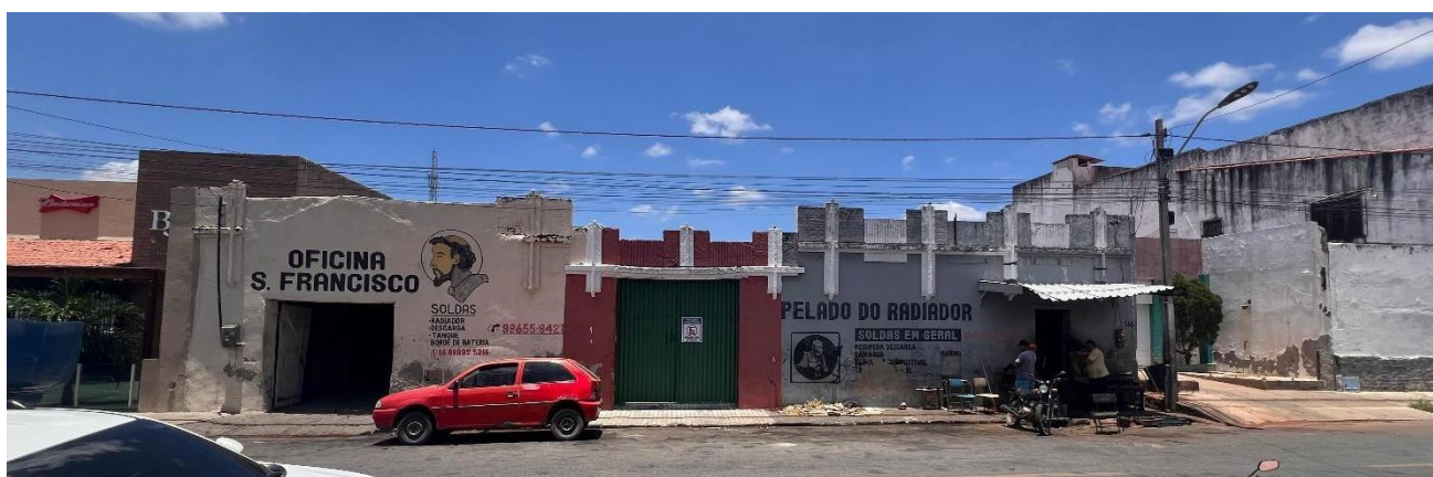
Fachadas em processo de descaracterização, atualmente utilizadas como oficinas.
