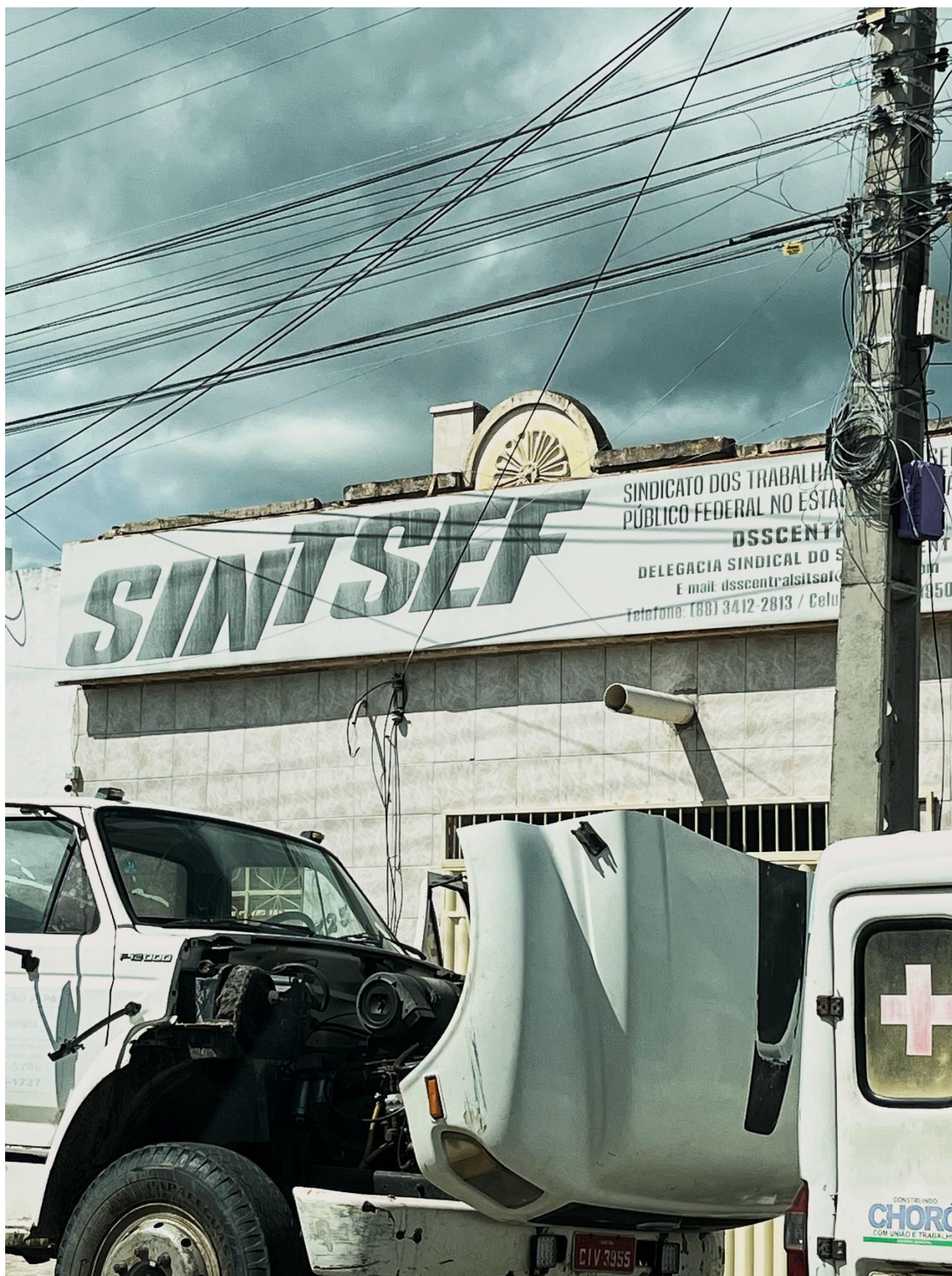
Ornamento que fazia parte da fachada, quase completamente descaracterizado.
