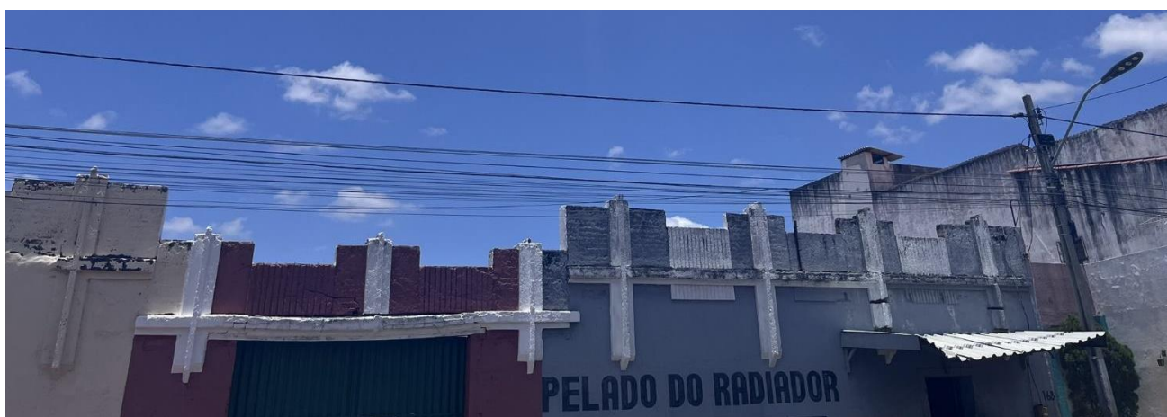
Detalhe aproximado das platibandas.
