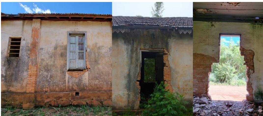
Figura 12: Detalhe das esquadrias do dormitório.
