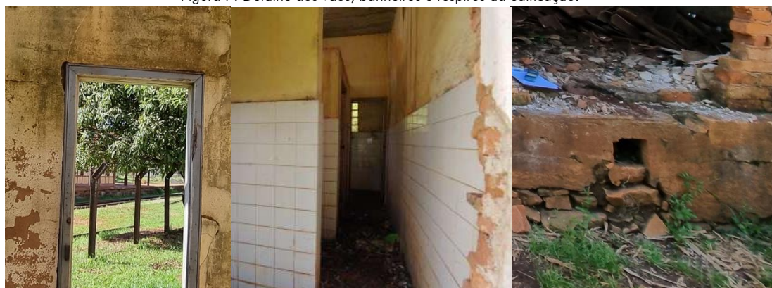
Figura 7: Detalhe dos vãos, banheiros e respiros da edificação.
