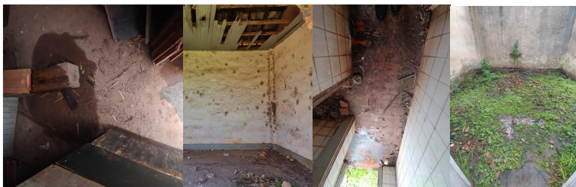
Figura 6: Sistema construtivo dos pisos: cimento queimado, tacos de madeira, lajota cerâmica e piso sem acabamento.
