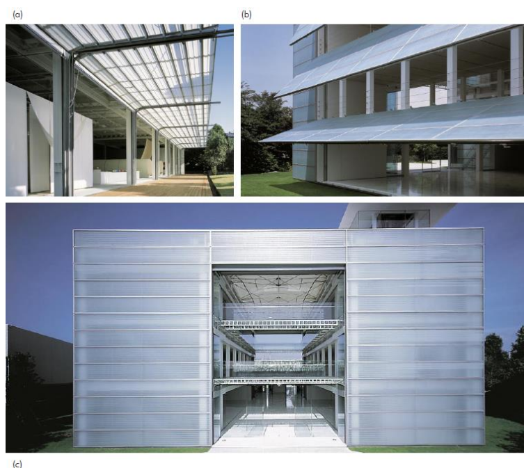
Figura 7: (a) Sistema de automação para abertura das vedações lateais; (b) Portões basculantes em painéis de plástico com fibra de vidro; (c) Fachada principal do Museu de Arte do Papel com painéis recolhidos para a abertura do acesso.
