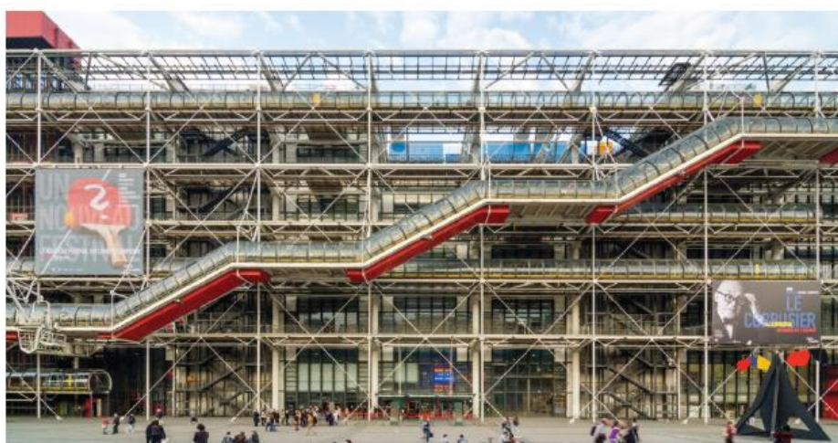
Figura 5: Fachada principal com duto da escada externa.
