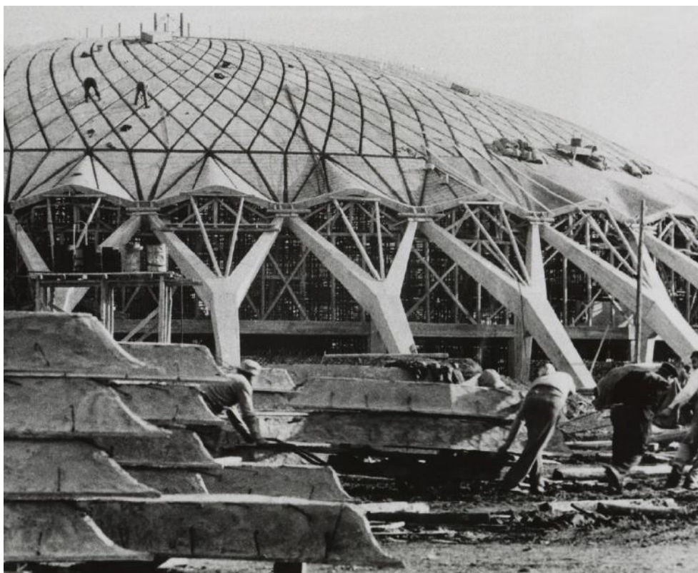
Figura 2: Construção do Palazzo dello Sport, Roma, etapa de montagem da cúpula nervurada da cobertura.
