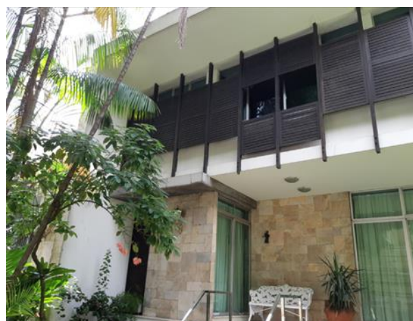
Figura 8: Detalhe dos brise-soleil nas janelas das suítes superiores – Av. Nazaré
