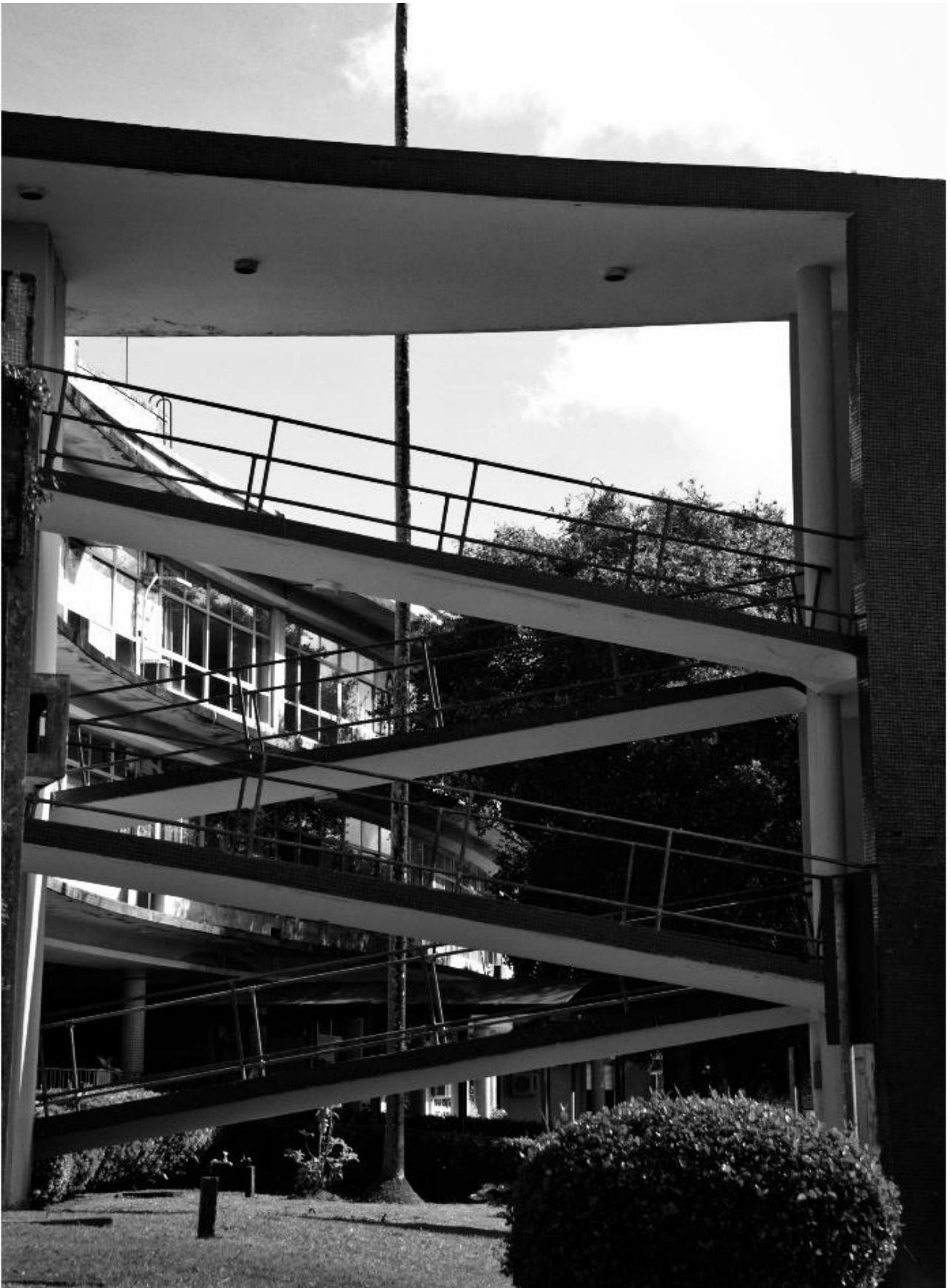
Setran-Pa, rampa lateral do prédio. Autoria: Carolina Magno, 2022.
