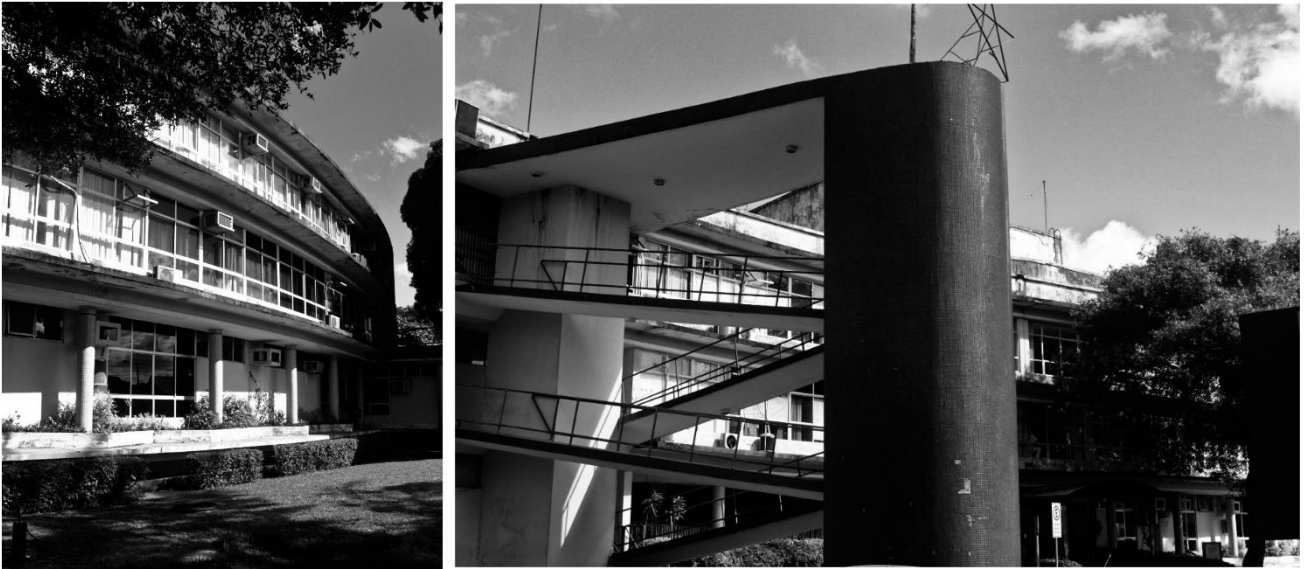
Setran-PA, detalhe para sinuosidade do edifício. Autoria: Carolina Magno, 2022.
