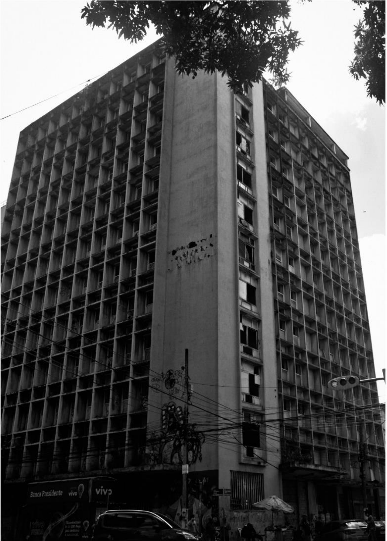
Edifício INAMPS. A autoria: Carolina Magno, 2022.
