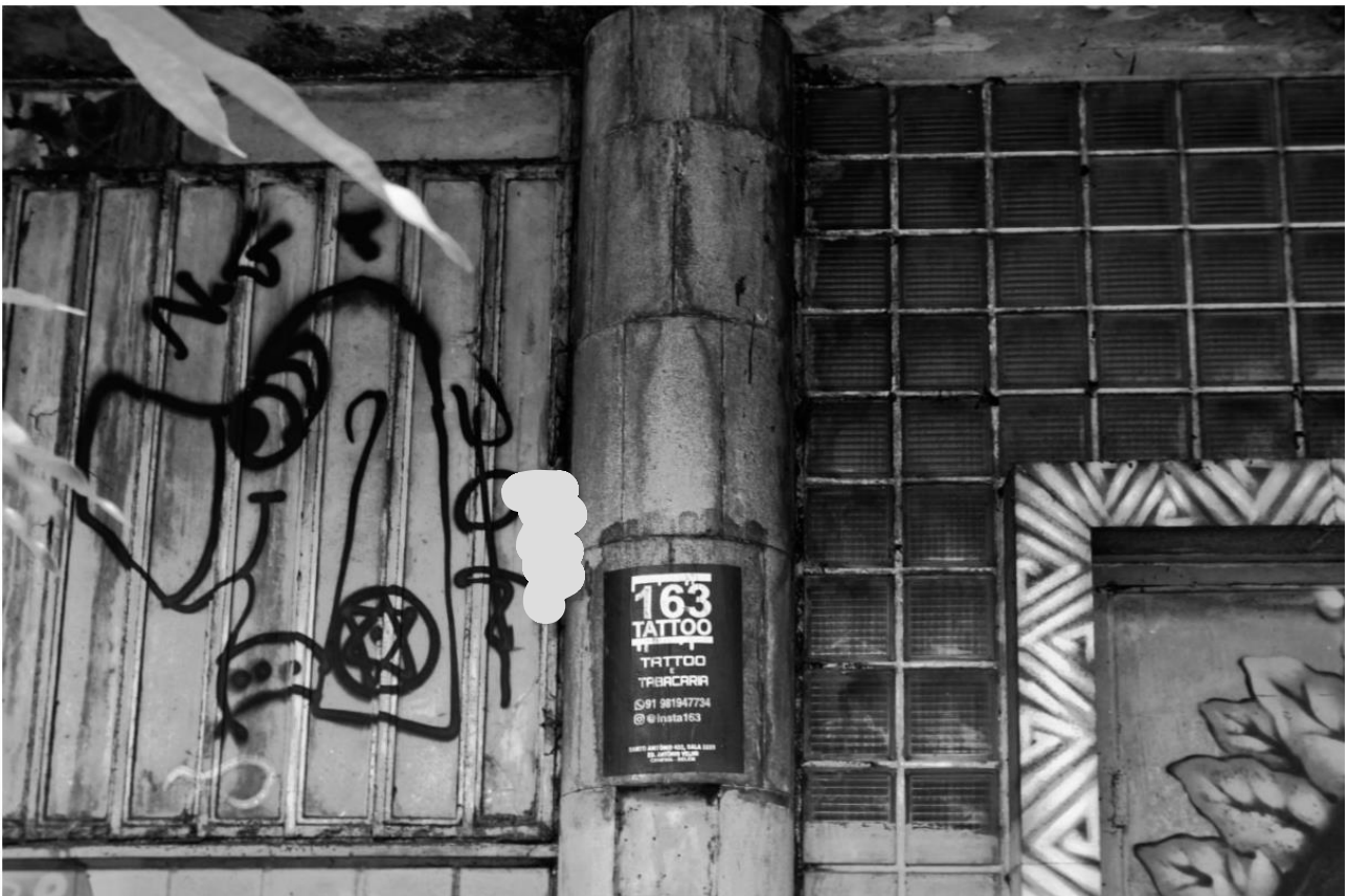
Detalhe de fechamento em cobogós de vidro. Autoria: Carolina Magno, 2022.
