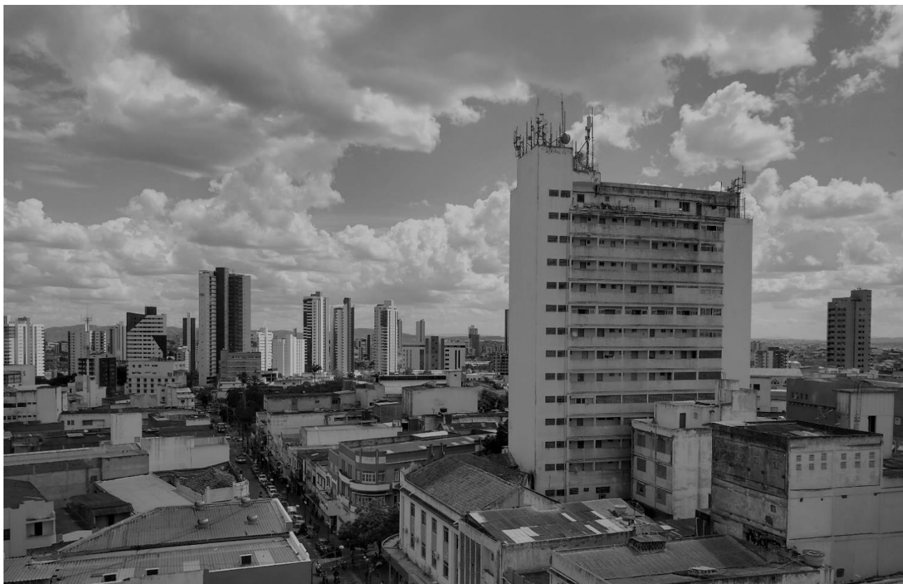
Figura 9: Vista da fachada posterior do Edifício Lucas.
