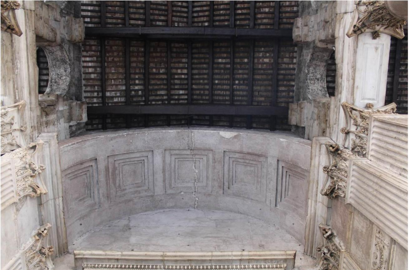
**Título:** Detalhe da estrutura de cobertura do pronaos – telhado de madeira reconstruído por Borromini
