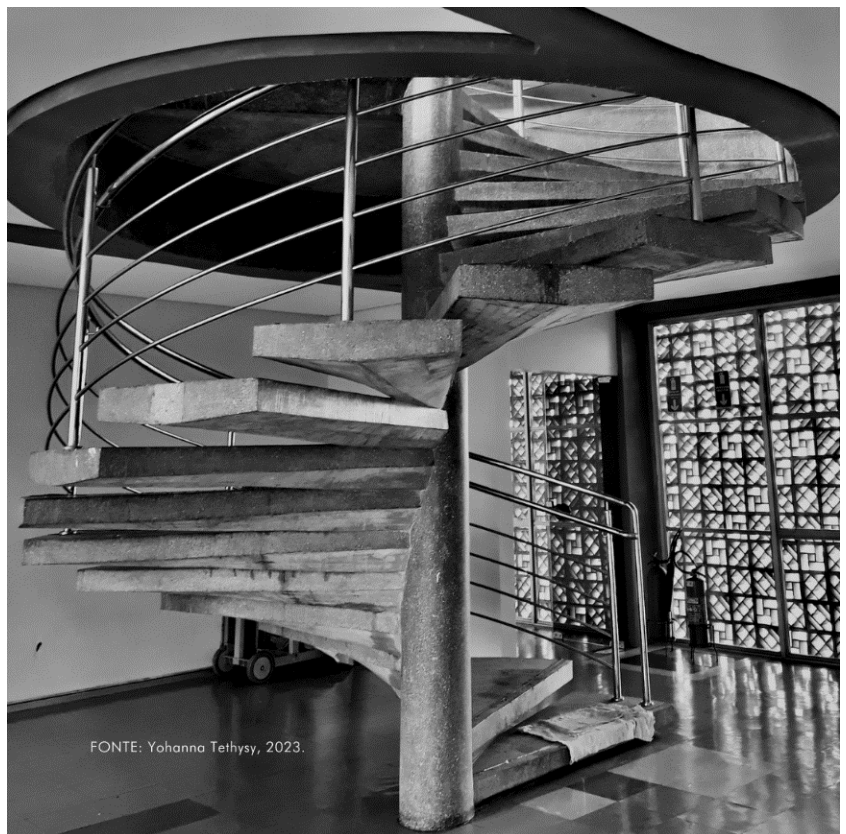
Detalhe da escada helicoidal existente no interior do bloco principal. Autoria: Yohana Tethys. CAU UFCG
