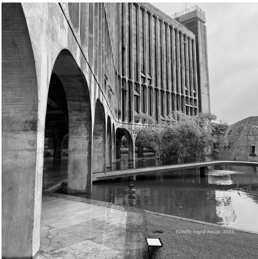
Detalhes dos pilares em concreto armado no pavimento térreo. Autoria: Ingrid Araújo. CAU UFCG
