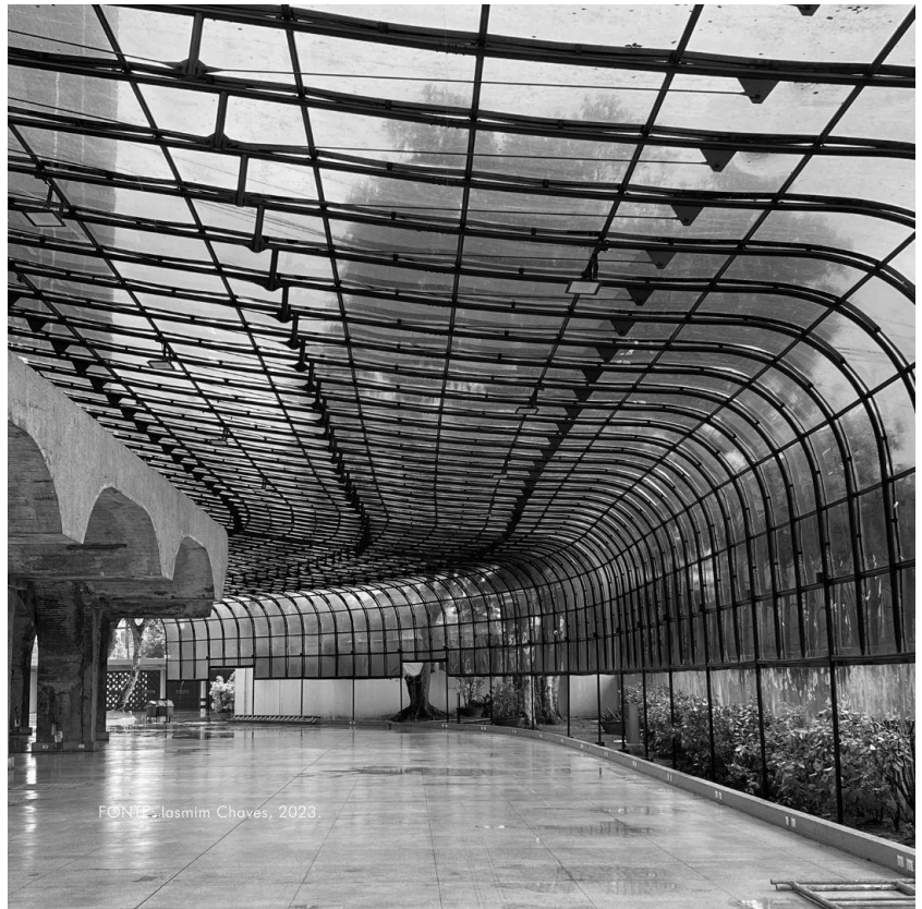
Imagem da cobertura realizada posteriormente, que aumenta a área coberta do pavimento térreo: Autoria: Iasmim Chaves. CAU UFCG
