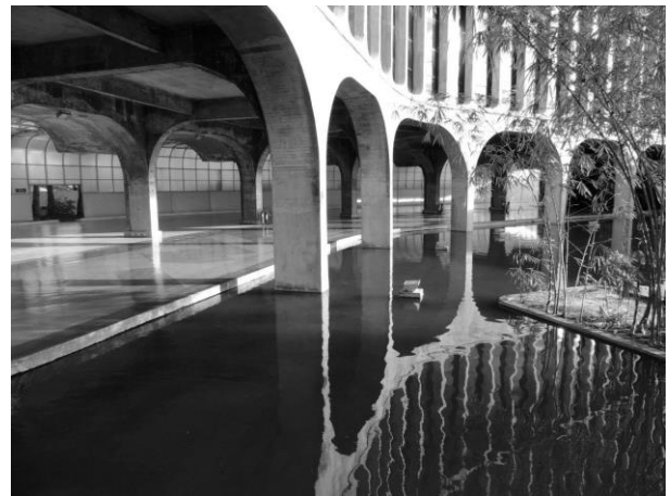
Arcadas em concreto aparente do pavimento térreo. Fonte: Alcilia Afonso. 2016.
