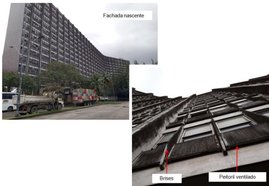
Figura 11: Fachada nascente com marcação vertical das estruturas pré-moldadas e com os brises e peitoril ventilado
