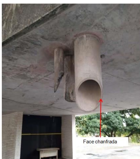
Figura 13: As três gárgulas com diâmetros distintos com faces chanfradas.
