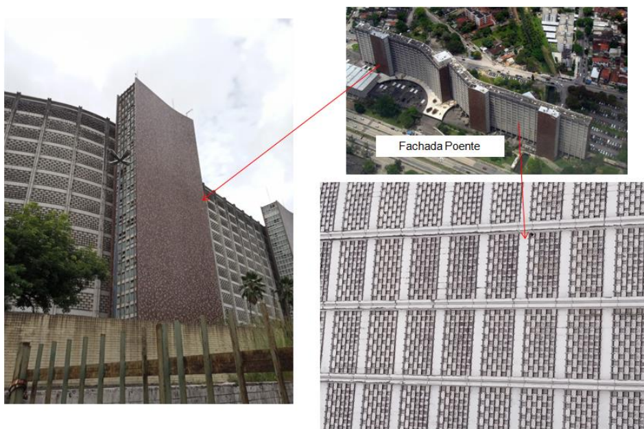
Figura 7: Fachada poente com uso de cobogó e de painel cerâmico com tons terrosos
