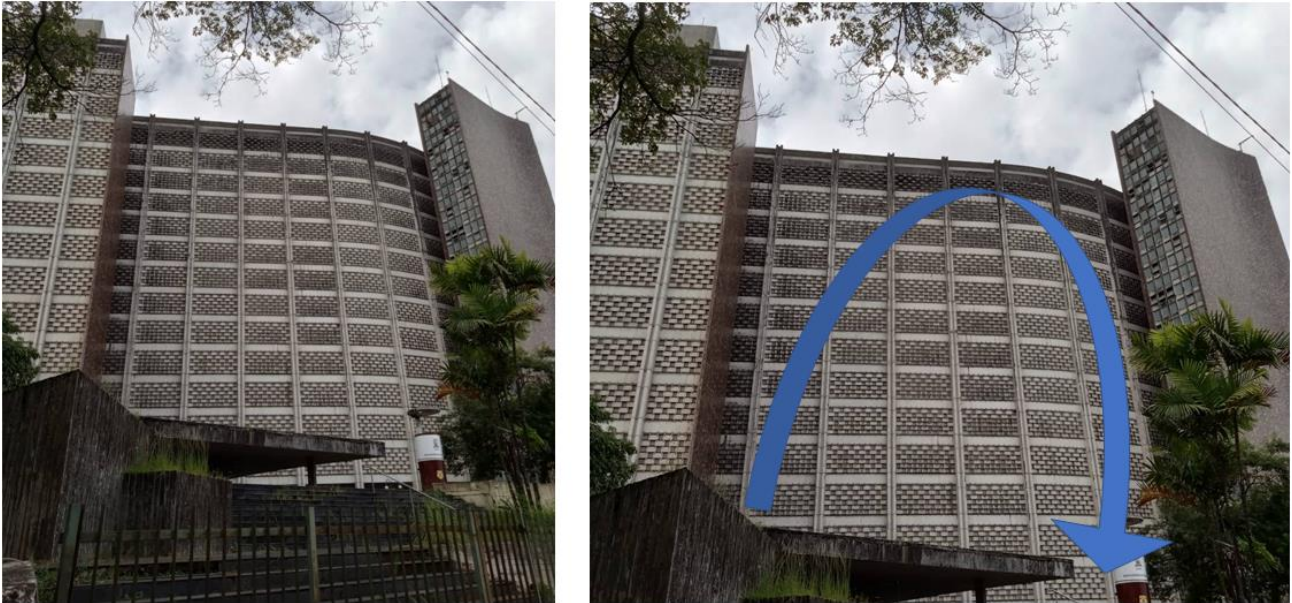
Figura 21: Vórtice gerando uma parábola de sujeidade na fachada oeste da Sede da SUDENE
