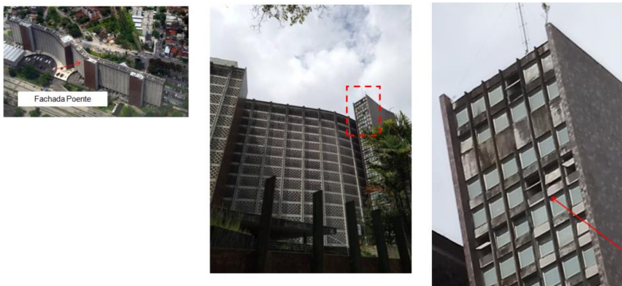
Figura 9: Fachada com uso de brises para minorar a incidência de iluminação
