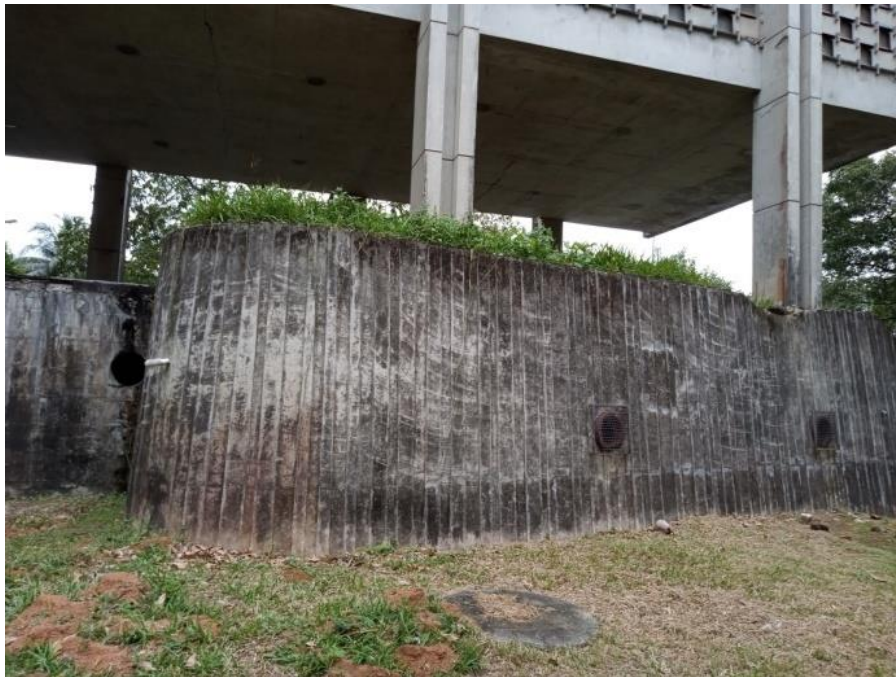
Figura 25: Texturização do embasamento da oeste com crosta negra, localizado próximo a passarela de acesso ao IFPE.
