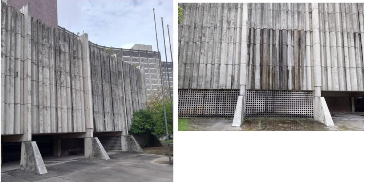
Figura 14: Fachada oeste do Auditório com marcação da fachada pelos pilares, com embasamento em contrafortes e fechamento em cobogós no subsolo.
