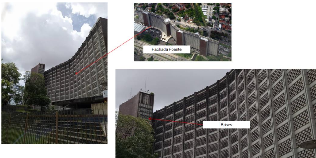
Figura 8: Fachada com uso de brises para minorar a incidência de iluminação
