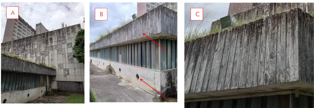
Figura 17: A fachada norte do auditório com placas em concreto
