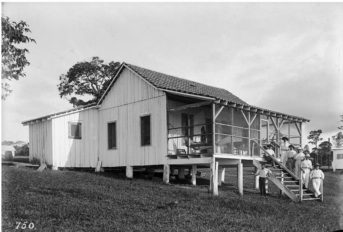
Figura 4: Residência para funcionários graduados.
